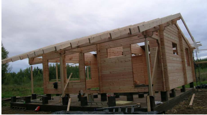
KUVA 5. Rakennusvaiheessa oleva hirsinen vapaa-ajan asunto. Valokuva Teemu Kirjavainen 2011.
