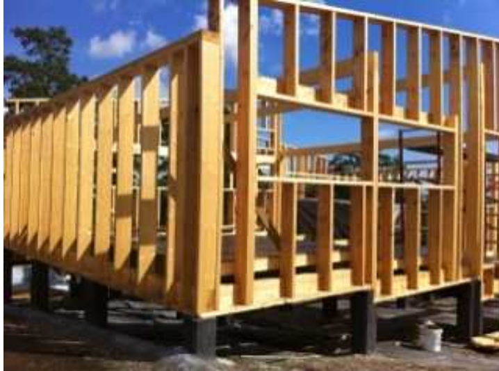
KUVA 1. Pre-cut-rakennuksen runko pystyttämisen jälkeen. Valokuva Paula Salovaara 2011.
