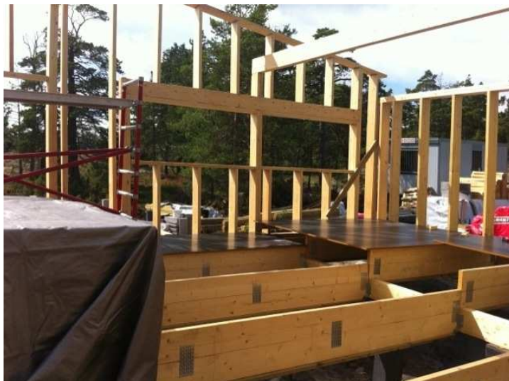
KUVA 2. Rakennuksen runkopuut ja kantavat rakenteet tuodaan työmaalle määrämittaan katkottuina ja lovettuina. Valokuva Paula Salovaara 2011.
