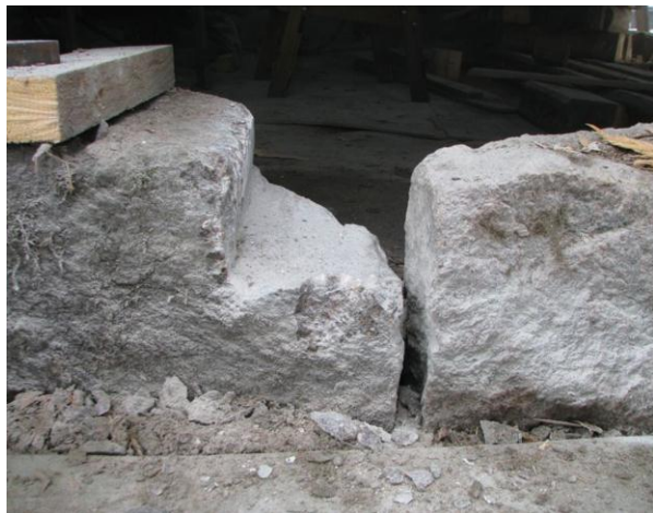
Kuva 24 Valmis tuuletusaukko eteläseinällä
