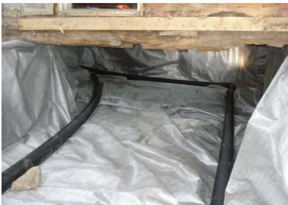
Kuva 15 Salaojaputkien asentelua suodatinkankaalle, kuva otettu keittiöstä kamarin suuntaan
