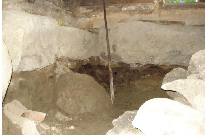
Kuva 14 Lopullinen kaivuussyvyys keittiön maapohjassa, n. 500 mm kivien alareunasta
