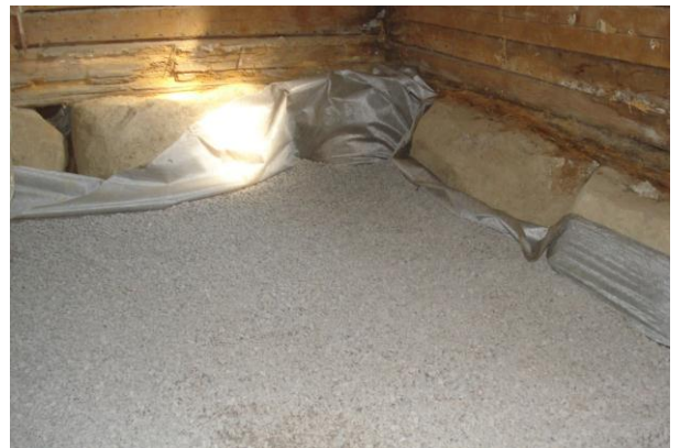
Kuva 16 Sorakerros kivien alareunaan asti, kamarin kaakkoisnurkka
