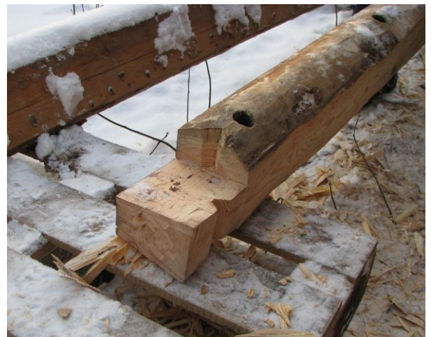
Kuva 21 Kaakkoisnurkan 3. hirren uusi lohenpyrstö, jossa myös lämminvarat
