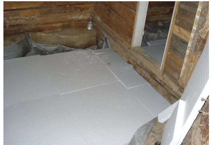
Kuva 18 Styrox kerroksen asennusta, kamari
