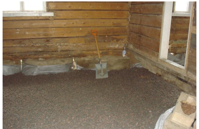
Kuva 19 Valmis maapohja, kamari
