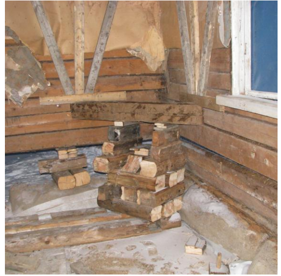
Kuva 20 Kaakkoisnurkan nostokohta
