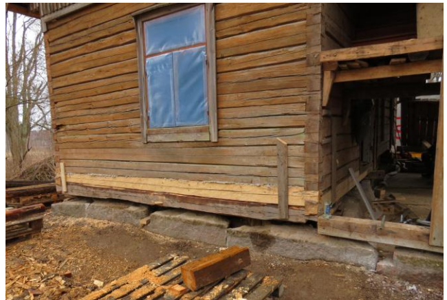
Kuva 22 Itäpääty on valmis
