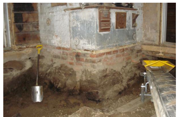
Kuva 13 Kivien alareunaan asti kaivettu, kuva on keittiöstä
