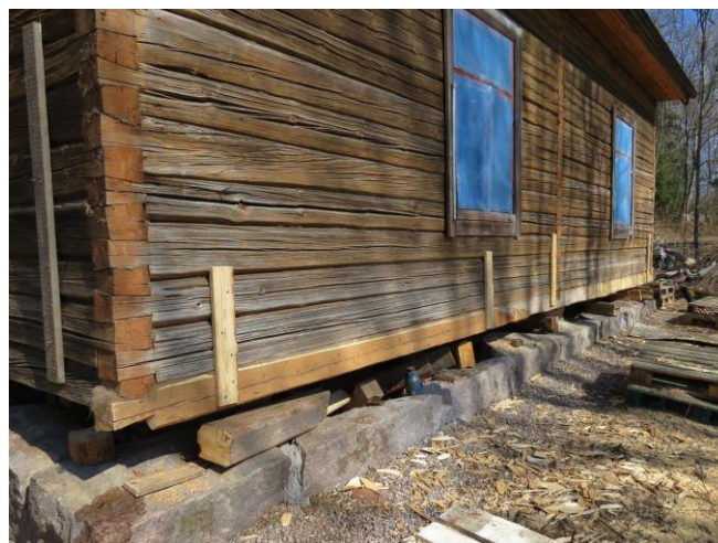
Kuva 23 Eteläsivun 2. hirsi valmiina
