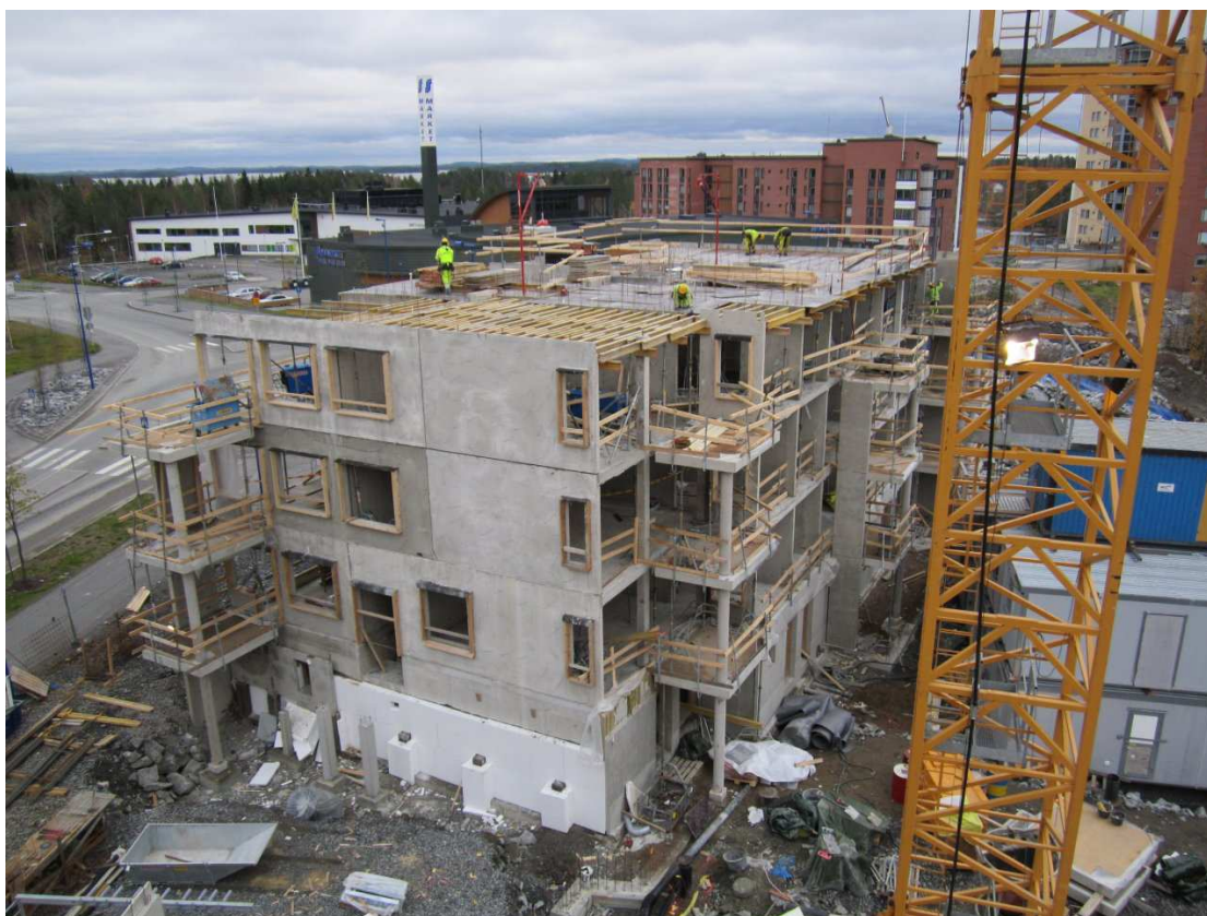
KUVA 12. Holvin laudoitusvaihe. Kuva Lauri Alanko, 2012.
