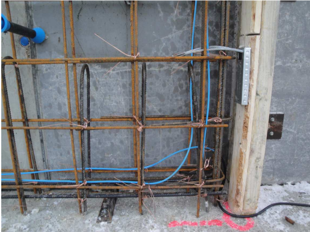
KUVA 18. Lankalämmitys valettavan seinän reuna-alueella. Kuvassa näkyy lisäksi seinän alaosan välike, johon toisen muottipuoliskon muottipinta asetetaan tiiviisti kiinni. Kuva Maiju Leskinen.
