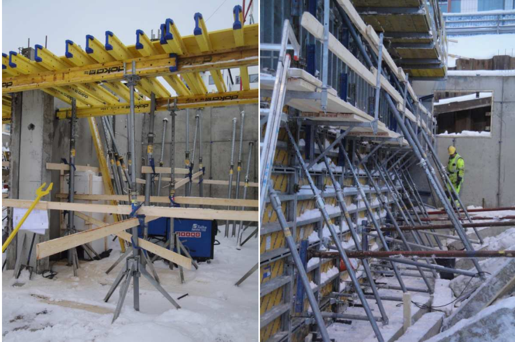
KUVA 4. Muottien tukirakenteita. Vasemmanpuoleisessa kuvassa on holvimuotin puiset tukirakenteet muotin jäykistämiseksi. Oikeanpuoleisessa kuvassa on viisi metriä korkean seinämuotin teräksisiä tukirakenteita. Kuva Maiju Leskinen.
