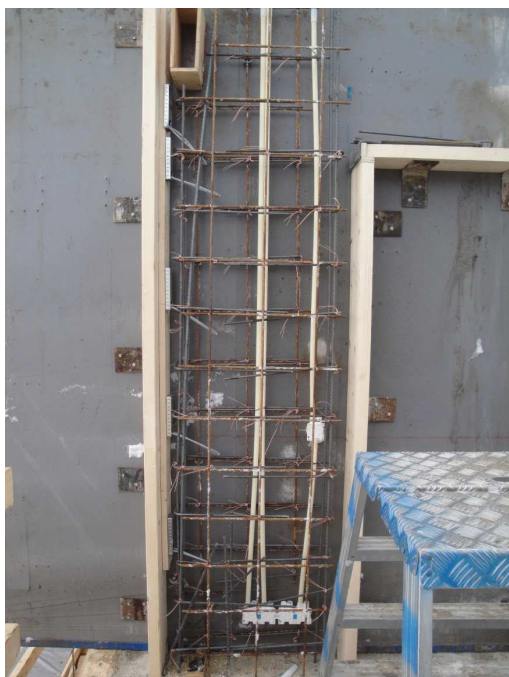
KUVA 8. Sähköasennuksia seinämuottipinnassa. Kuva Maiju Leskinen.
