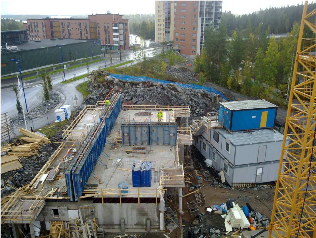
KUVA 2. Suurmuottikierron ensimmäinen päivä. Seinien valaminen aloitetaan pitkistä seinistä. Kuva Lauri Alanko, 2012.
