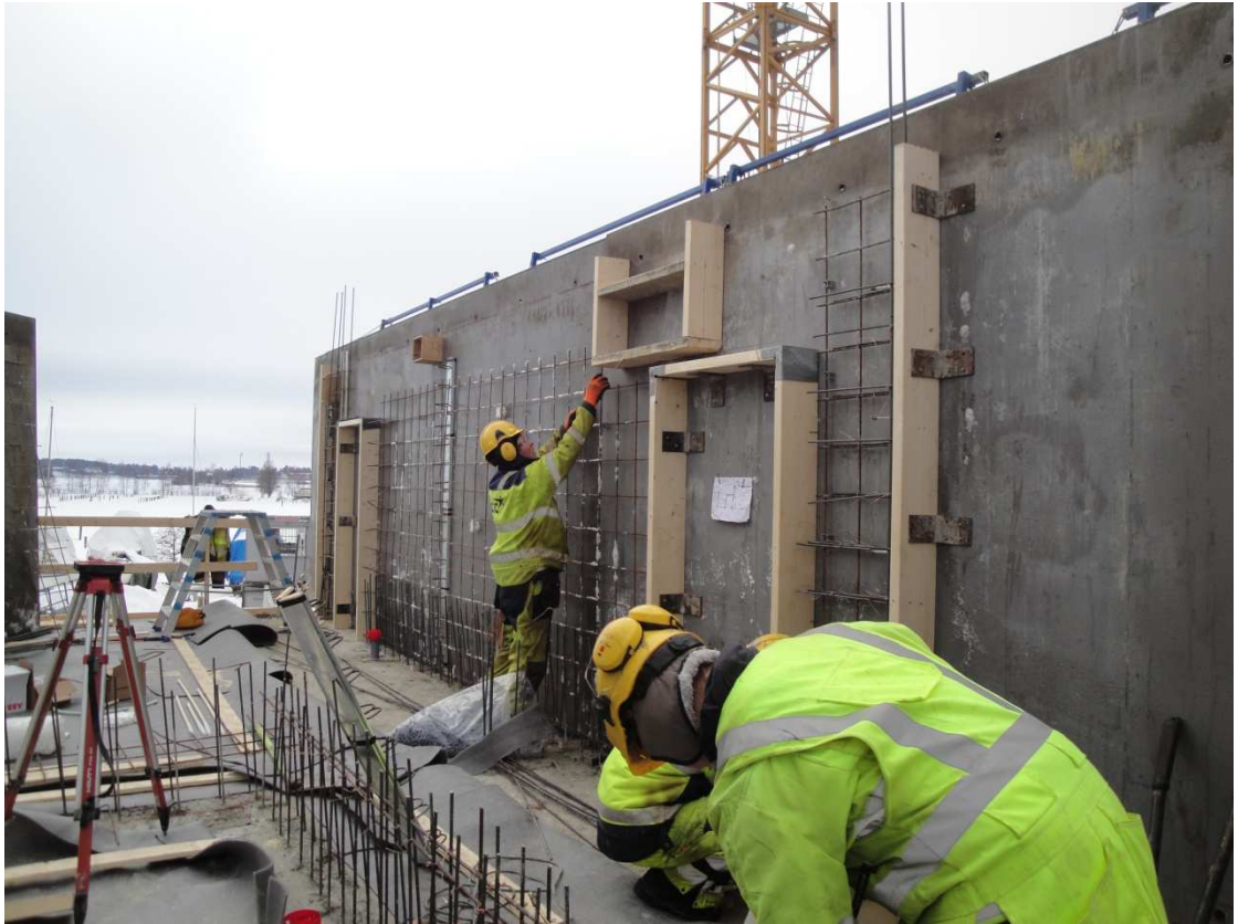
KUVA 9. Raudoituksen asentaminen suurmuottiin. Kuvassa näkyvät myös seinän päätytopparit ja muun muassa oviaukkojen varaukset sekä muut reikä varaukset. Kuva Maiju Leskinen.
