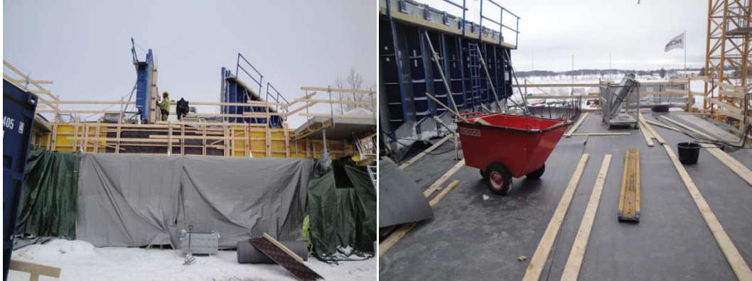
KUVA 20. Holvin suojaus valun jälkeen. Kuva Maiju Leskinen.
