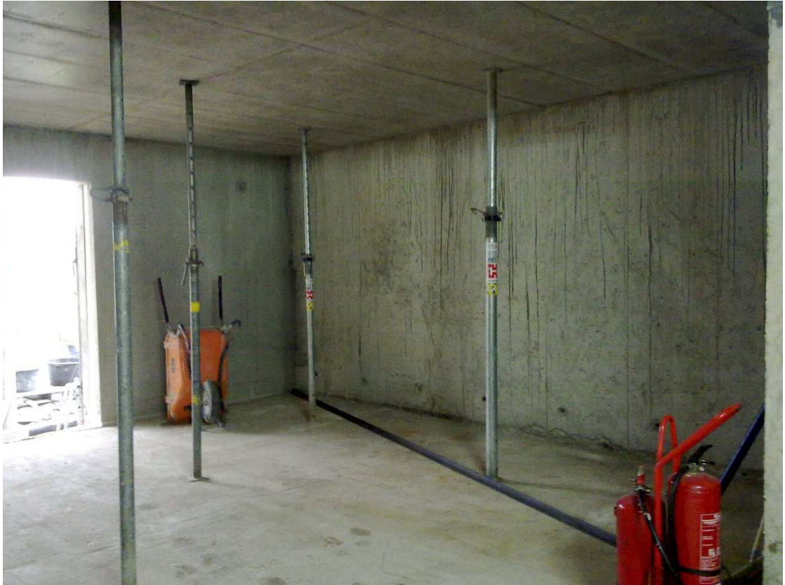
KUVA 13. Holvin jälkituenta muottien purkamisen jälkeen. Kuva Lauri Alanko, 2012.
