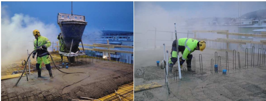
KUVA 16. Holvin valaminen nostoastialla ja betonipinnan hiertäminen pesuhuoneiden kohdalla. Kuvat Maiju Leskinen.
