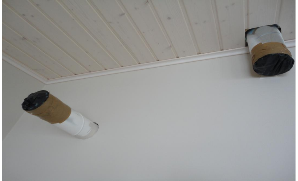
Kuvio 1. Ilmanvaihtoaukkojen ja viemärien tiivistyksiä.
