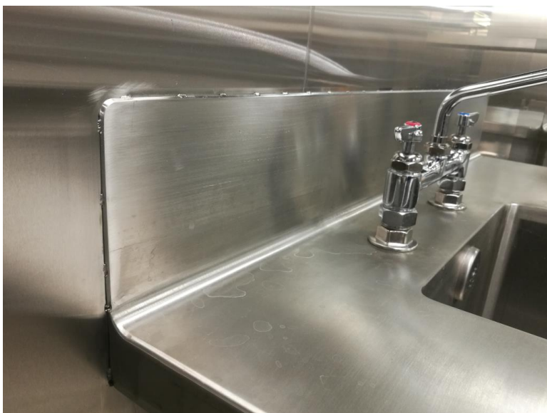
Kuva 4. Tiskipöydän taustaseinä pyörityksellä, kiinnitetty seinään katkohitsillä (Meyer Turku Oy 2017)
