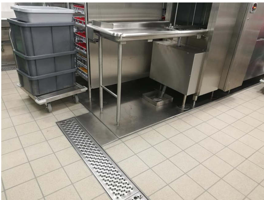
Kuva 16. Matala laitealusta keskellä lattiaa jonka vieressä ojakouru sekä ritilä (Meyer Turku Oy 2017)
