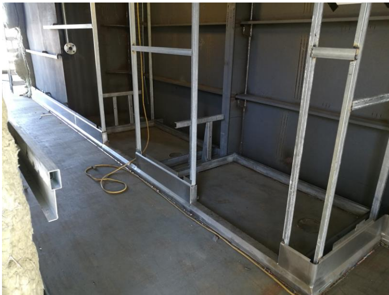
Kuva 15. Kuvassa rajaraudat hitsattuna kanteen sekä seinän taustakoolaus tehtynä (Meyer Turku 2017)
