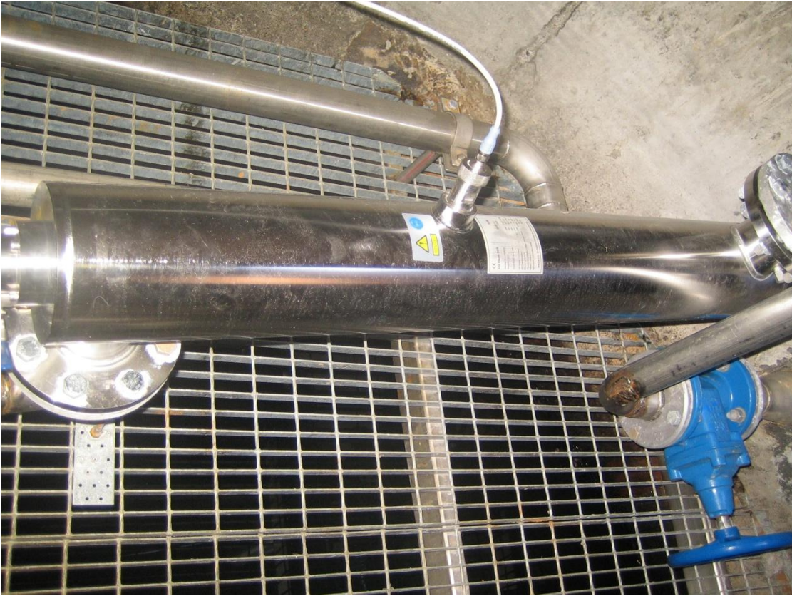
Kuva 4. Yksi raakaveden puhdistusmenetelmistä on UV-desinfiointi. Valokuva Linda Luostarinen 2012.
