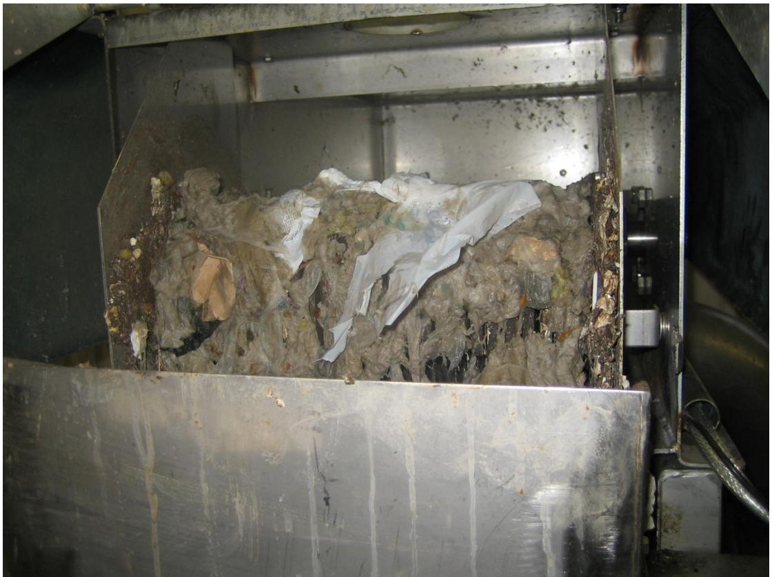
Kuva 6. Porrasväljän jätevedestä erottelemia suuria kiinteitä aineita ja roskaa. Valokuva Linda Luostarinen 2012.
