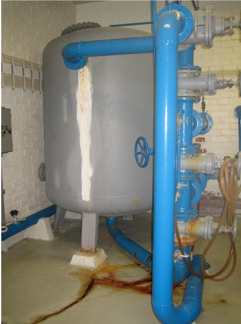
Kuva 5. Soodaa sekoitetaan talousveteen säiliössä ennen vedenjakelua. Valokuva Linda Luostarinen 2012.
