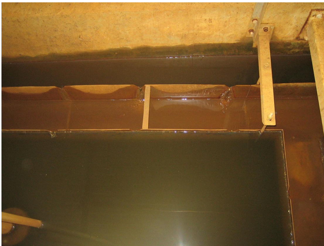
Kuva 8. Selkeytysaltaiden pinnalta puhdistunut vesi kerätään kouruihin ja kuljetetaan eteenpäin. Valokuva Linda Luostarinen 2012.
