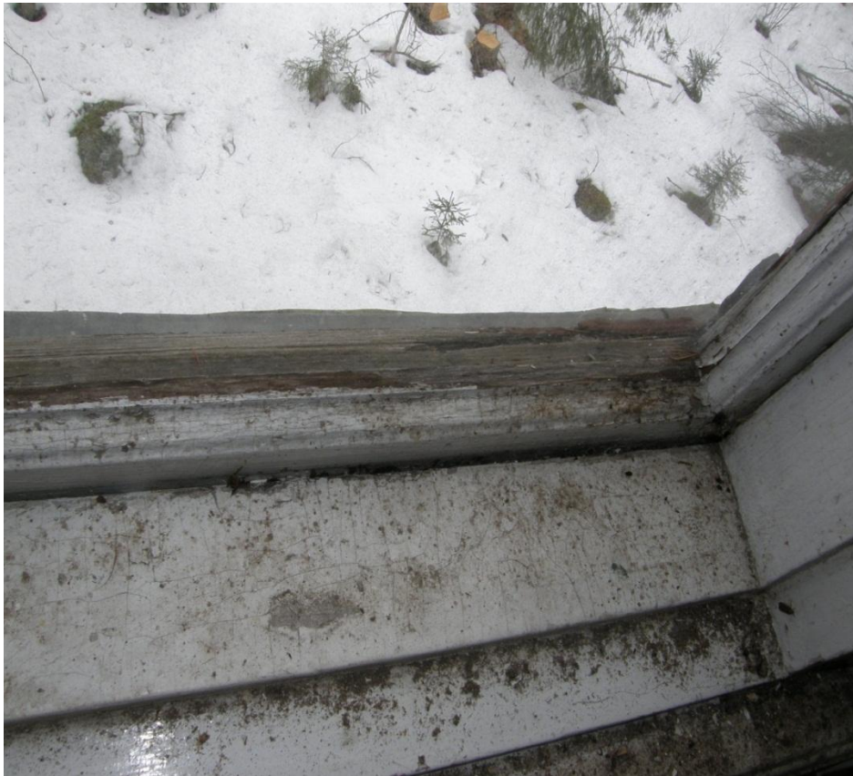
Kuvio 18. Ulomman ikkunapuitteen harmaantuminen.
