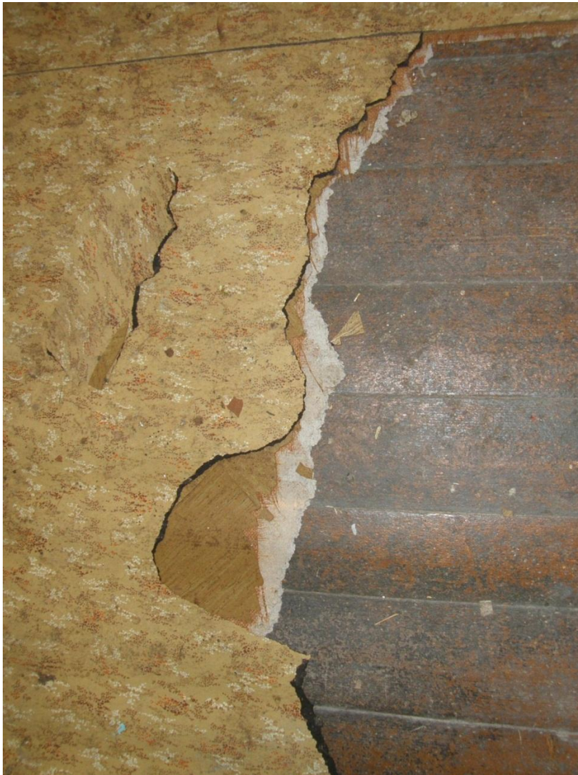
Kuvio 33. Kahden muovimaton alta paljastunut ehjä lautalattia.
