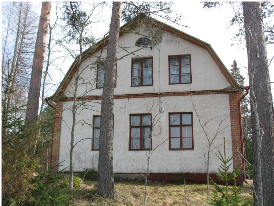
Kuvio 9. Julkisivukuva luoteeseen.
