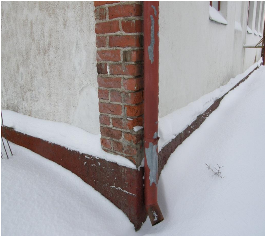
Kuvio 24. Syöksytorstesta lohkeillut maali.
