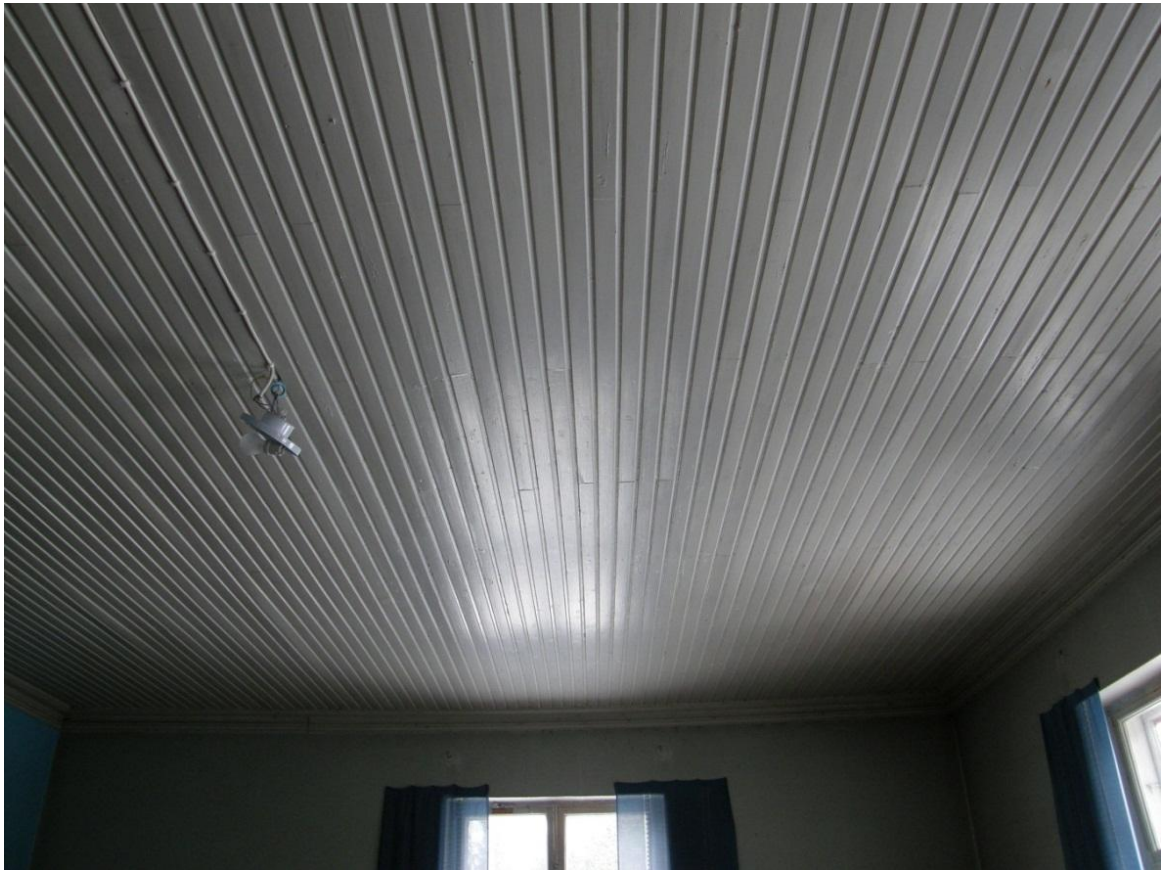
Kuvio 31. Alkuperäinen virheetön maalipinta.
