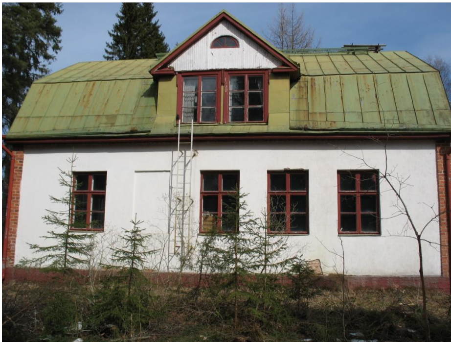
Kuvio 5. Julkisivukuva lounaaseen.
