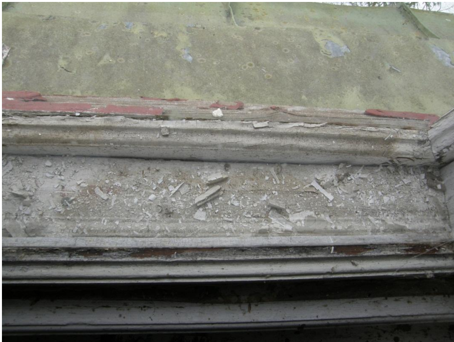
Kuvio 19. Ikkunakittien irtoilu ja maalin lohkeilu.
