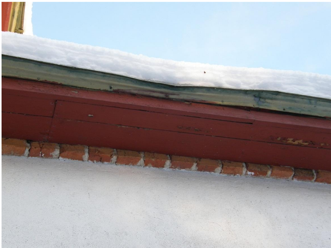
Kuvio 22. Seinäpintaan vettä roiskiva jalkaränni.
