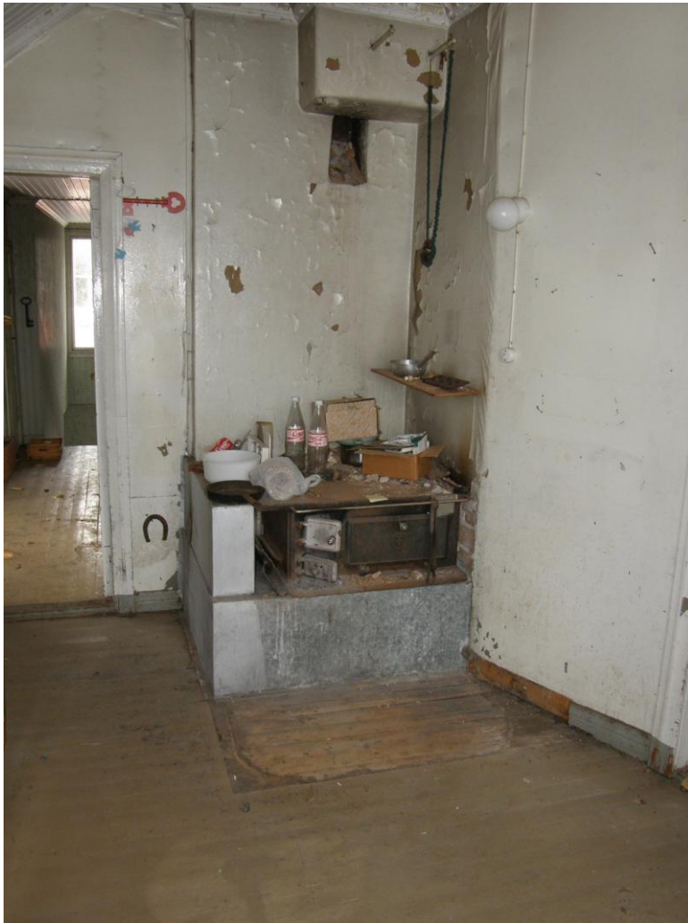
Kuvio 40. Liesi, jonka paikalle suihkukaappi rakennetaan.
