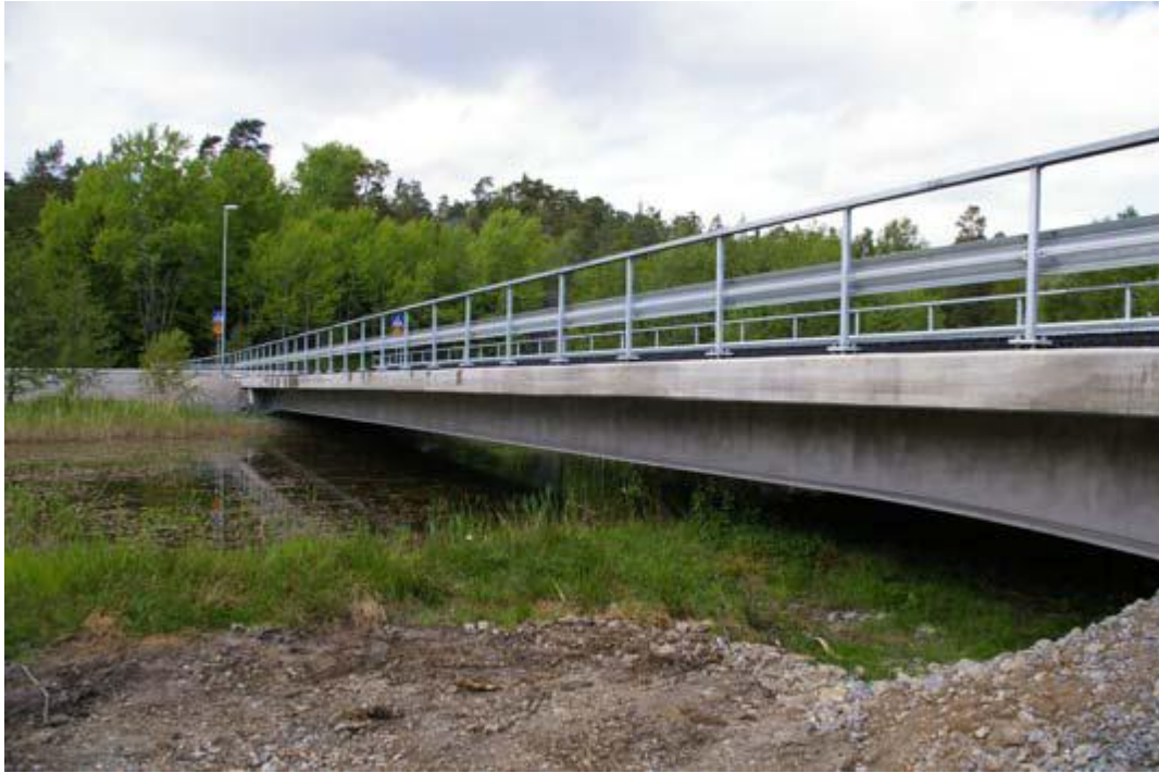
Kuva 6. Nynäshamnin silta (SBI Stålbyggnad 4/2011, 48)
