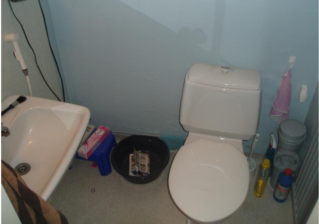
Kuva 16. Wc-tilan mitat ovat niin pienet, ettei sitä ole mahdollista muuttaa liikkumisesteisen käyttöön.
