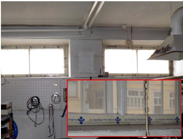
Bild 18 F3 Fönster I källaren finns en del fönster som inte är tätas, dessa fönster bör tätas eller bytas ut.
