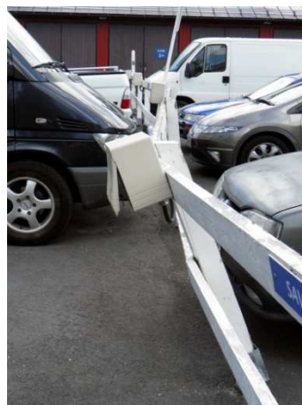
Bild 3 D8 Områdesutrustning, Staket Staketet bör bytas ut, då det är söndrigt.
