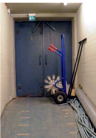
Bild 25 F5 Förkompletterade innerdelar, Dörrar Dörrarna är i gott skick, en del av dörrarna har tappat färg och kunde målas om.
