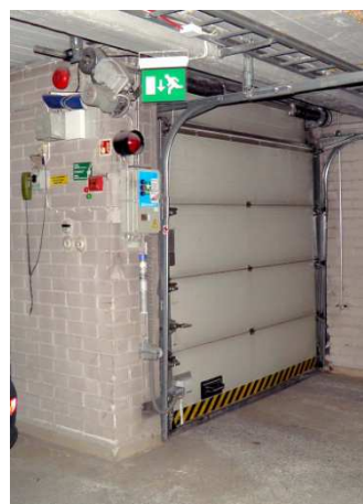
Bild 46 H7 Säkerhetsbelysning I hela byggnaden finns utrymningsvägar väl utmärkta med LED belysning.
