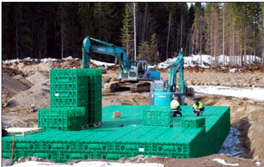
KUVA 44. Stormbox -hulevesijärjestelmän asennusta Nurmijärvellä 2011 (Pipelife 2012)
