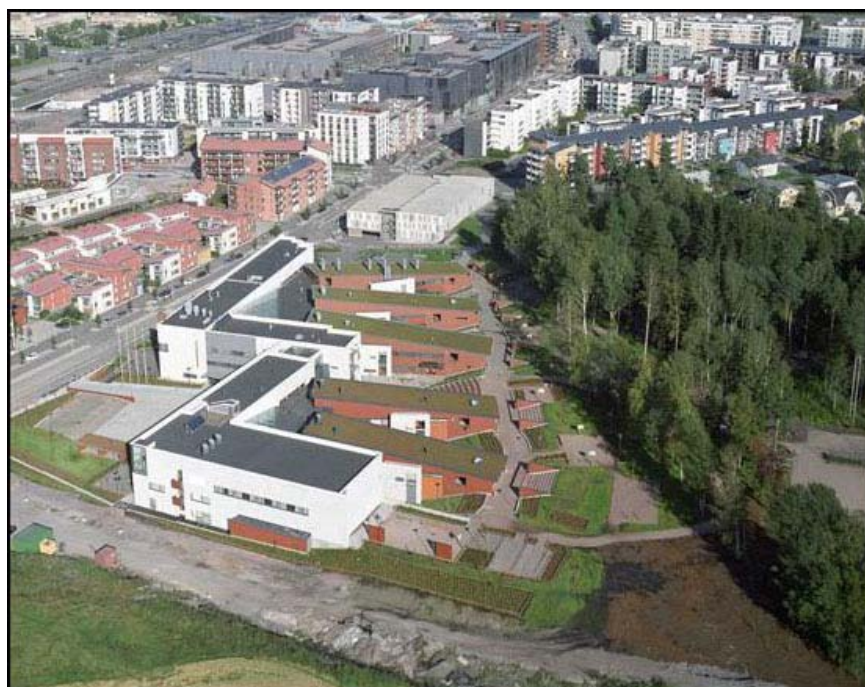
KUVA 45. Ruusutorpan koulurakennuksen viherkatto (Espoon kaupunki 2012)
