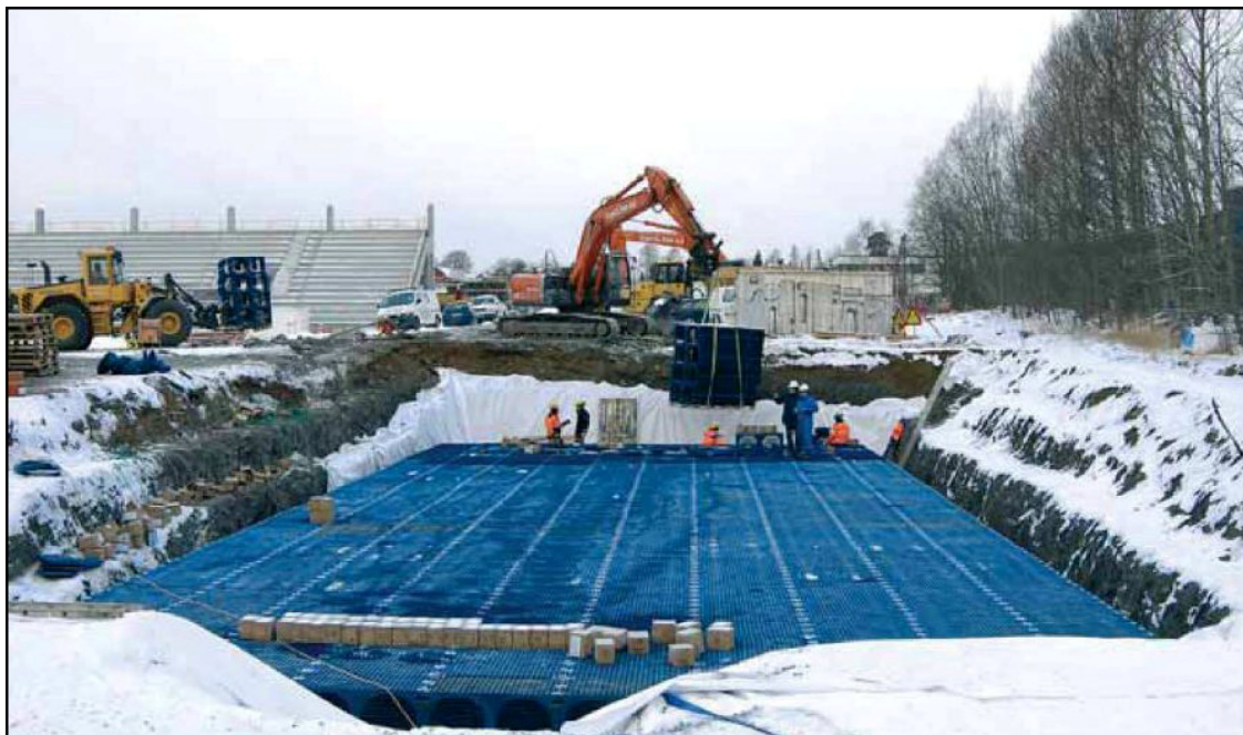
KUVA 19. Muovikennostolla täytetty maanalainen hulevesien imeytys- ja viivytyskaivanto (Finnish Consulting Group Oy 2009, 23)
