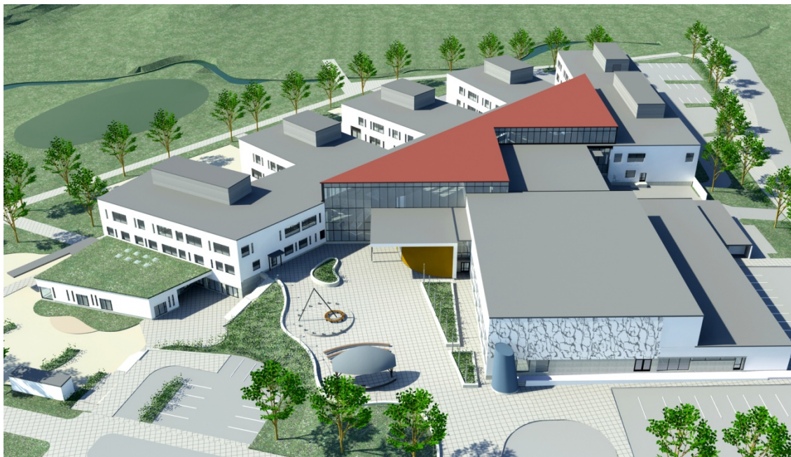
KUVA 54. Vuoreksen koulukeskus, julkisivu länteen (Tampereen kaupunki 2012e)
