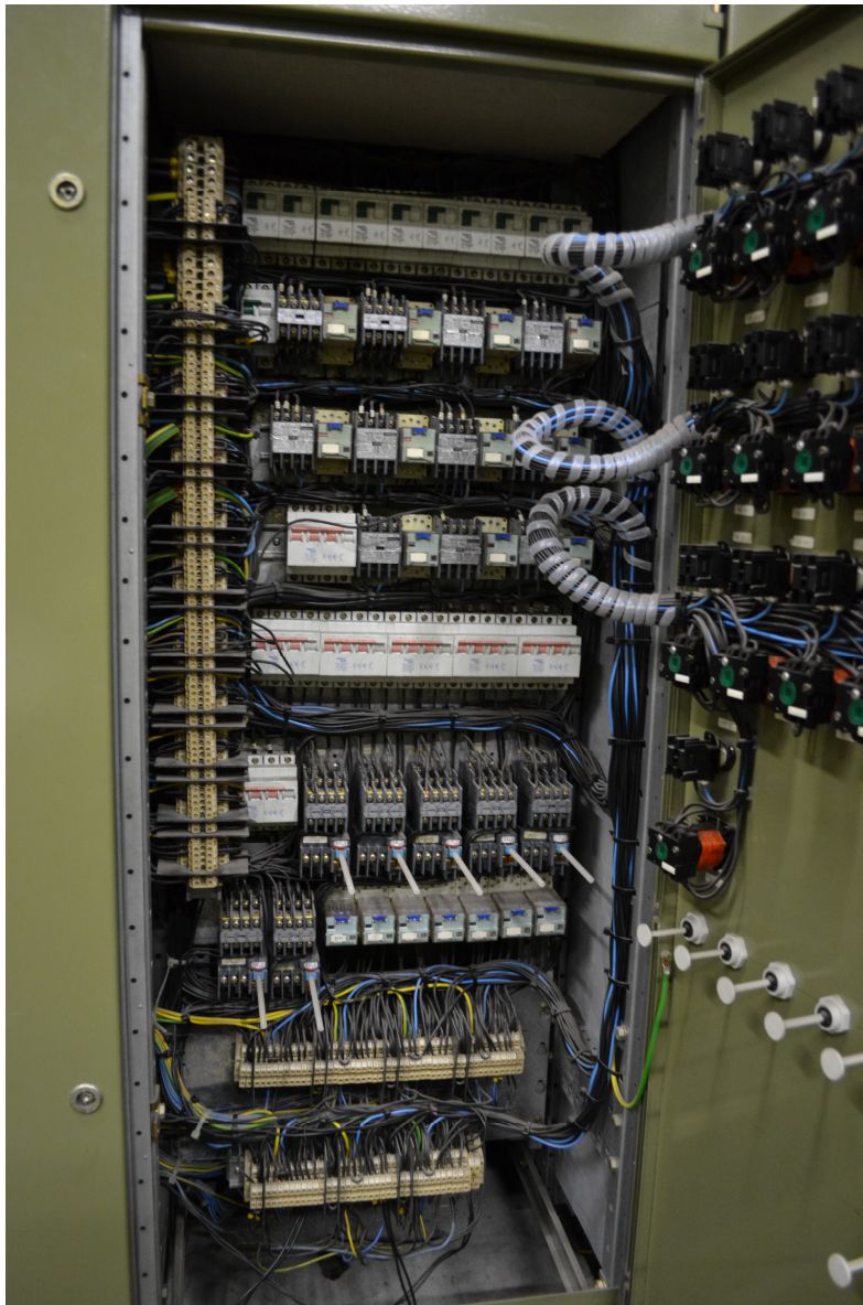
Kuvio 8. ABB Service, Oulun pääkeskuksen kontaktorilähtöjä
