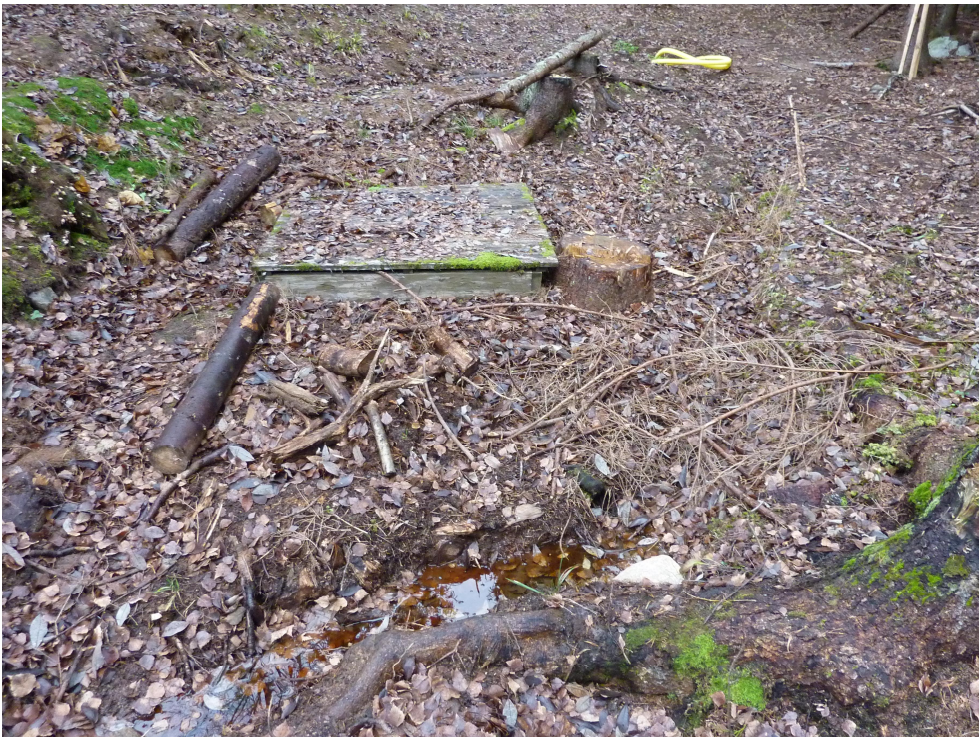
Kuva 6. Loma-asunnon kaivo Karjalohjalla.
