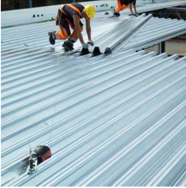
KUVIO 14. Asentaja, jolla päällään kokovaljas, kiinnitettynä turva-ankkuriin.
