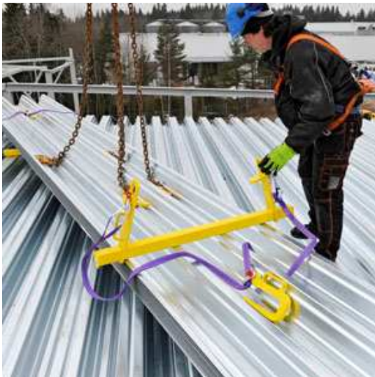
KUVIO 3. Kantavan poimulevyn nostoapuväline. (Ruukki 2012.)
