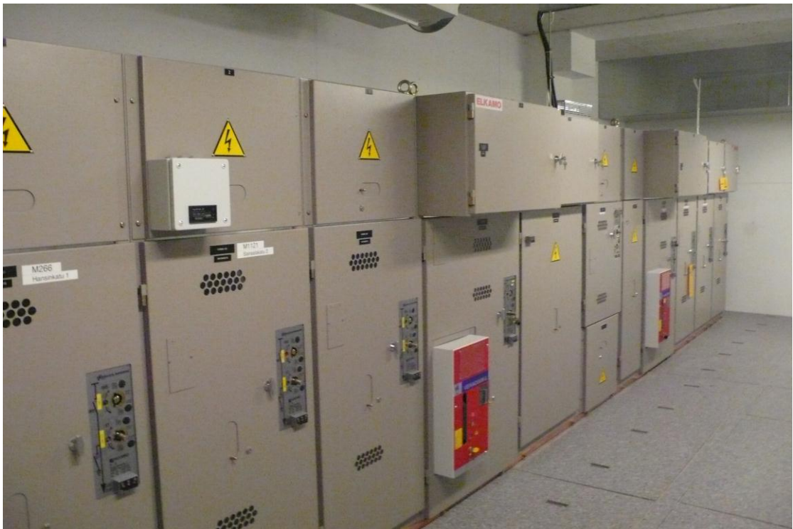
Kuva 5. Keskijännitekojeistokennosto
