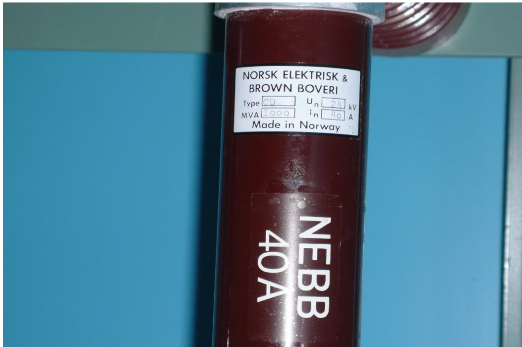
Kuva 8. Suurjännitesulakkeen arvokilpi
