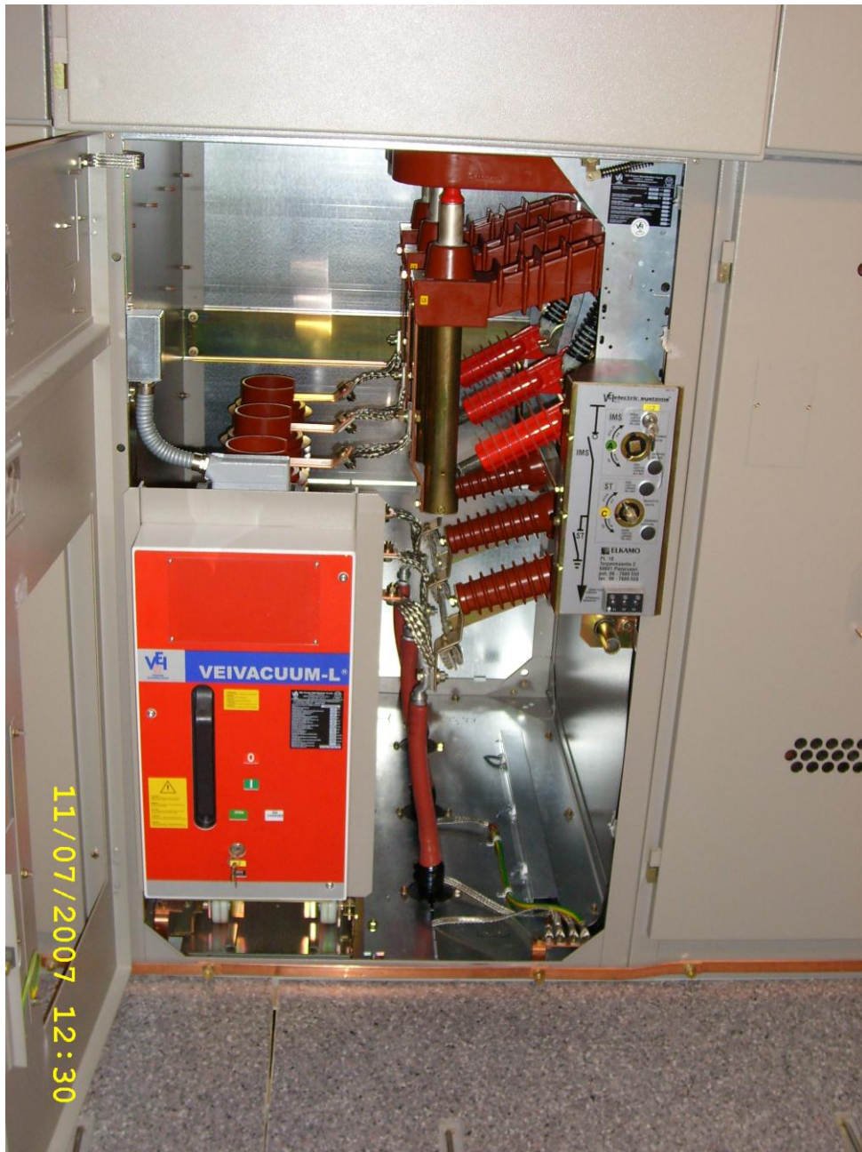
Kuva 6. SF 6 katkaisija ja erotin
