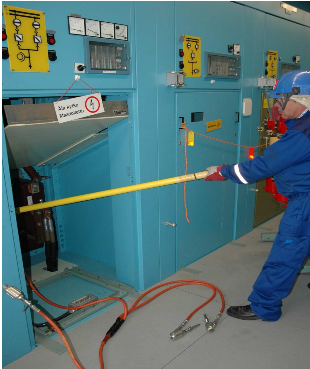
Kuva 13. Siirrettävä työmaadoitusväline
