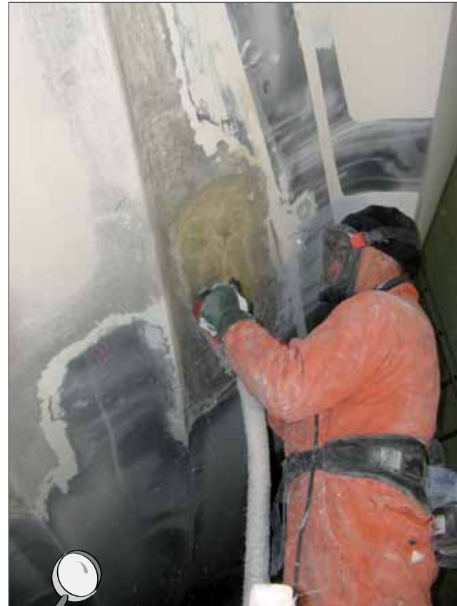
Kuva 3. Vaurioituneen laminaatin poistoa
