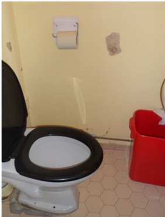
Kuva 11. Toisen kerroksen vessatila
