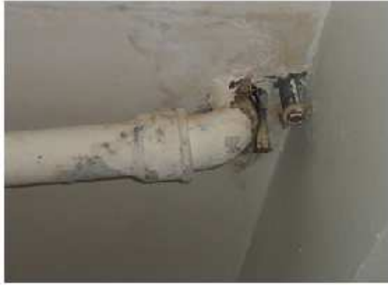
Kuva 20. Käyttövesiputkiston entinen läpivienti
