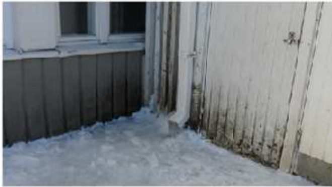
Kuva 4. Purusiilon ja seinän yhtymäkohta
