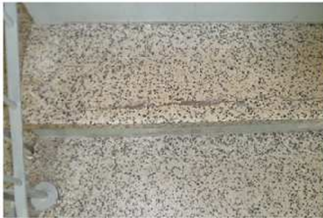
Kuva 11. Porrasaskelmat pääsisäänkäynniltä toiseen kerrokseen
