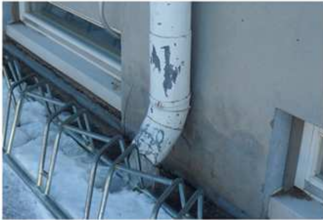
Kuva 3. Pihan puoleisen syöksytorven alaosa
