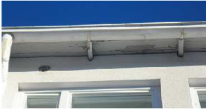
Kuva 9. Räystäät ja räystäskourut
