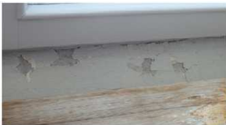
Kuva 7. Tuuletusikkunan alapuolinen seinä
