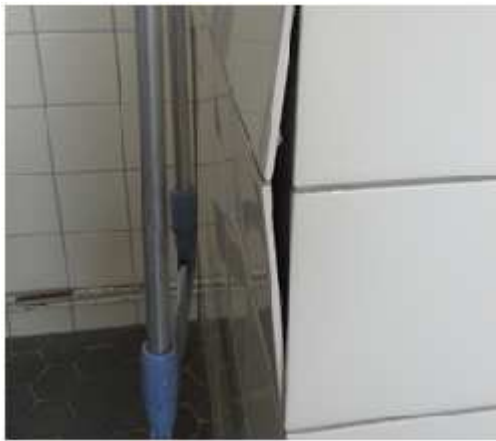
Kuva 13. Ensimmäisen kerroksen siivoojien taukotilan suihkunurkkaus
