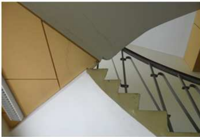
Kuva 6. Hahtolan puoleinen porrashuone
