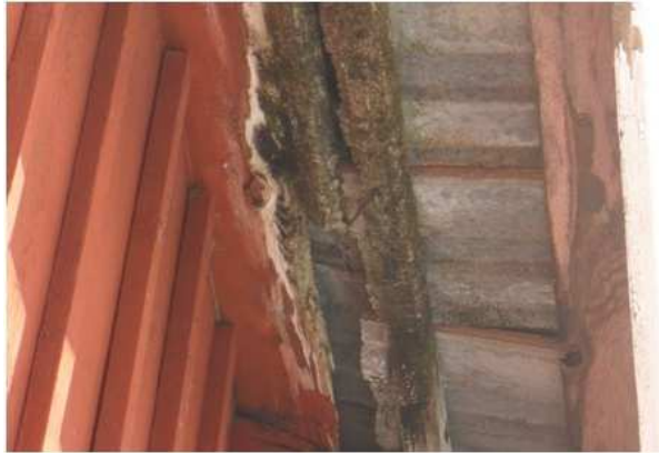
Kuva 1. Saunan räystääs kuistin kohdalla
