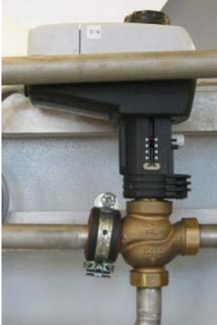
KUVA 13. Sunttiventtiili E9
