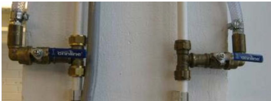
KUVA 2. Kylmä- ja kuumahana (seinä)
