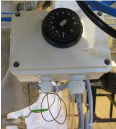
KUVA 7. Reaktorin lämpötilavarmistin
