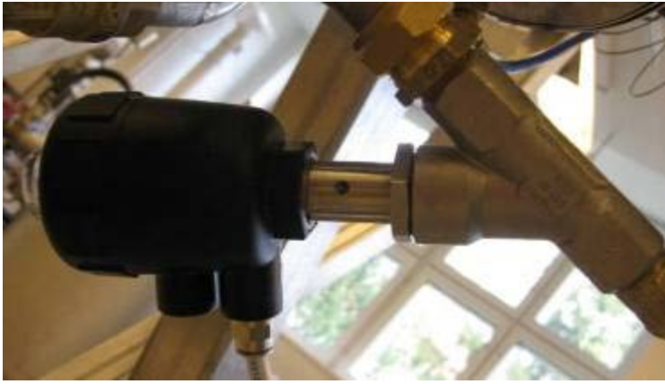
KUVA 19. Kulmaistukkainen ulkopuolelta ohjattava venttiili
