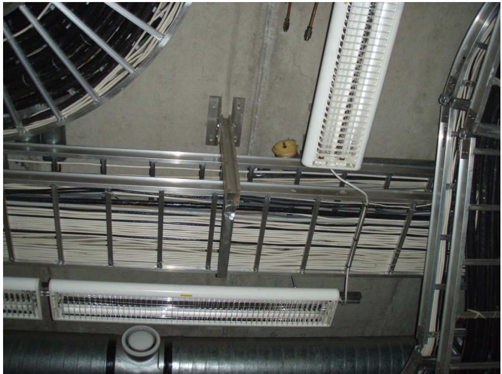
Kuva 16. Vanhemman osan kaapelointi
