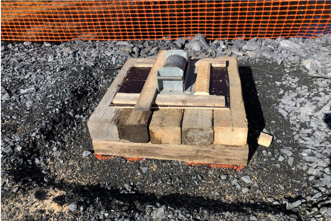
KUVA 10. Liukurullat oli hyvä tukea paikoilleen ylimääräisillä laudoilla, joilla estettiin liukurullien liikkuminen lanseerausvaiheessa
