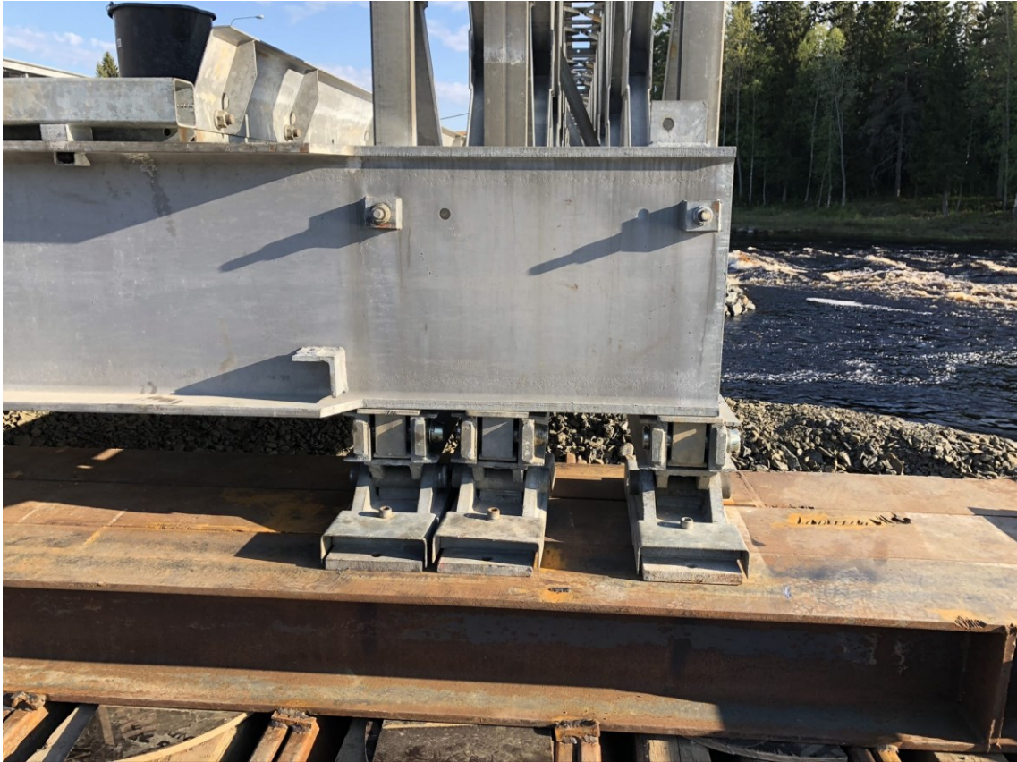
KUVA 32. Varasillan haarukkapään tunkkaus valmiina
