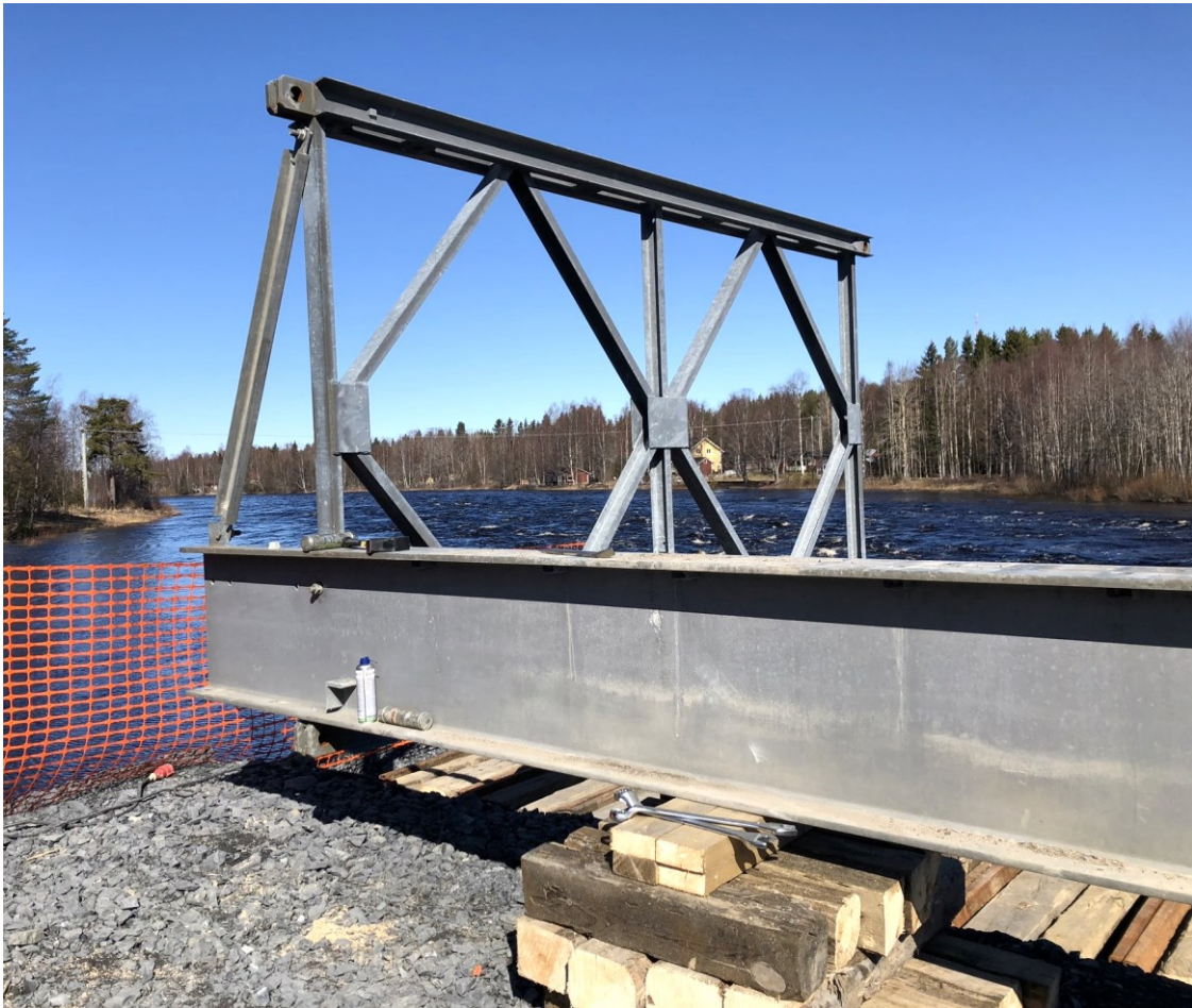
KUVA 15. Ensimmäisen kehäjakson asennus valmiina
