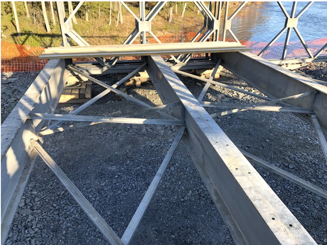
KUVA 22. Tuulisteet ja niskan pystysiteet asennettiin sileät pinnat vastakkain
