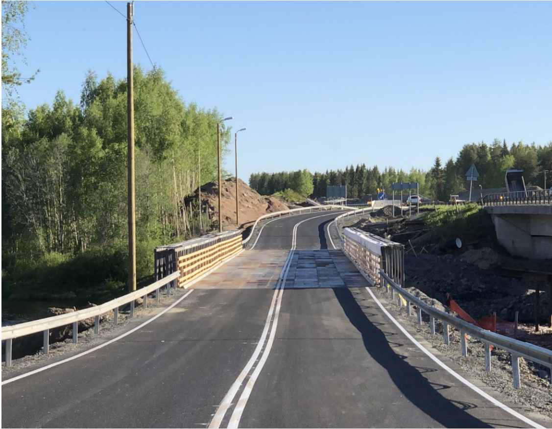
KUVA 34. Varasilta valmiina käyttönotolle
