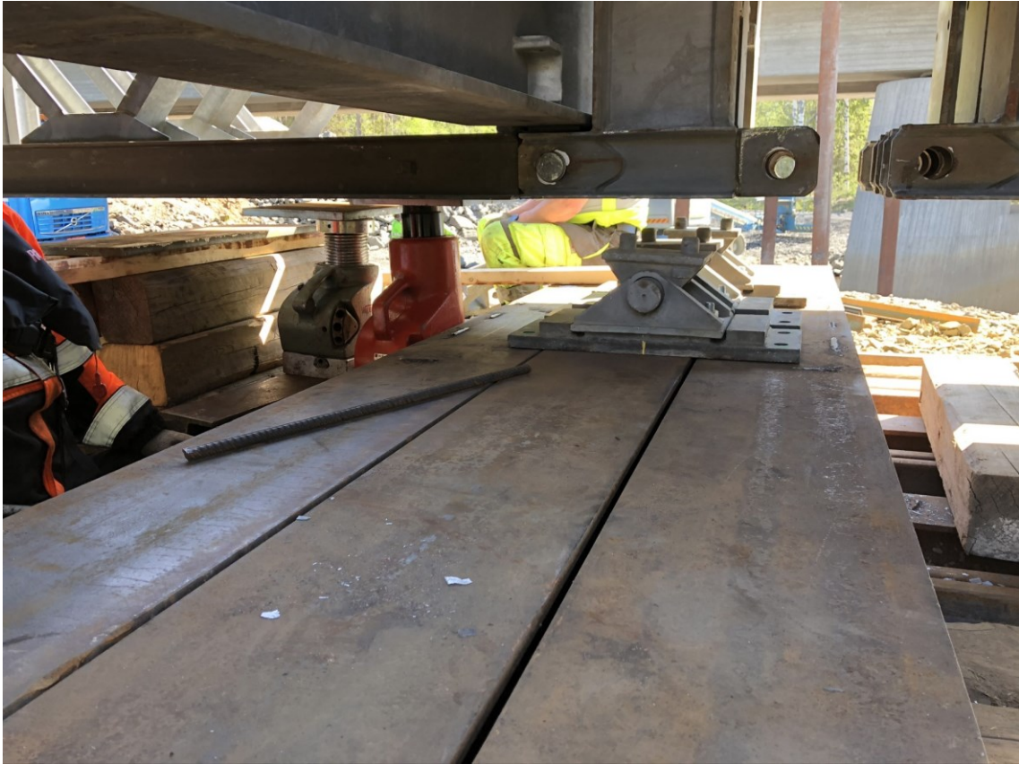
KUVA 31. Varasillan vaiheittaisessa tunkkauksessa käytettiin kahta erikokoista tunkkia
