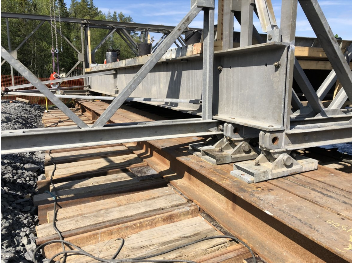
KUVA 33. Asennusperä oli paikoillaan karapään tunkkauksen ajan
