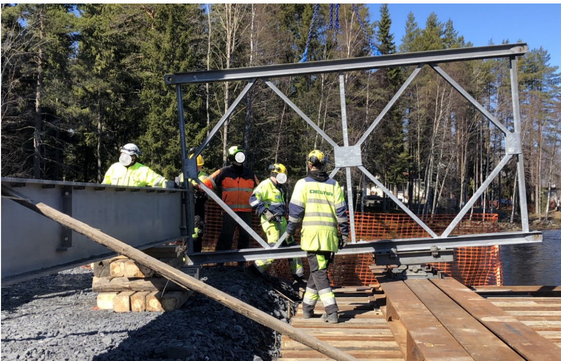
KUVA 14. Kehäelementti laskettiin tukirullan päälle, minkä jälkeen se kiinnitettiin niskaan
