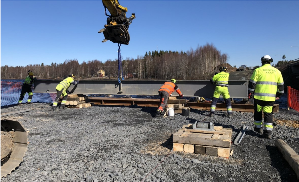
KUVA 13. Niska asetettiin paikoilleen apupelkkatukien merkintöjen sekä linjalangan avulla
