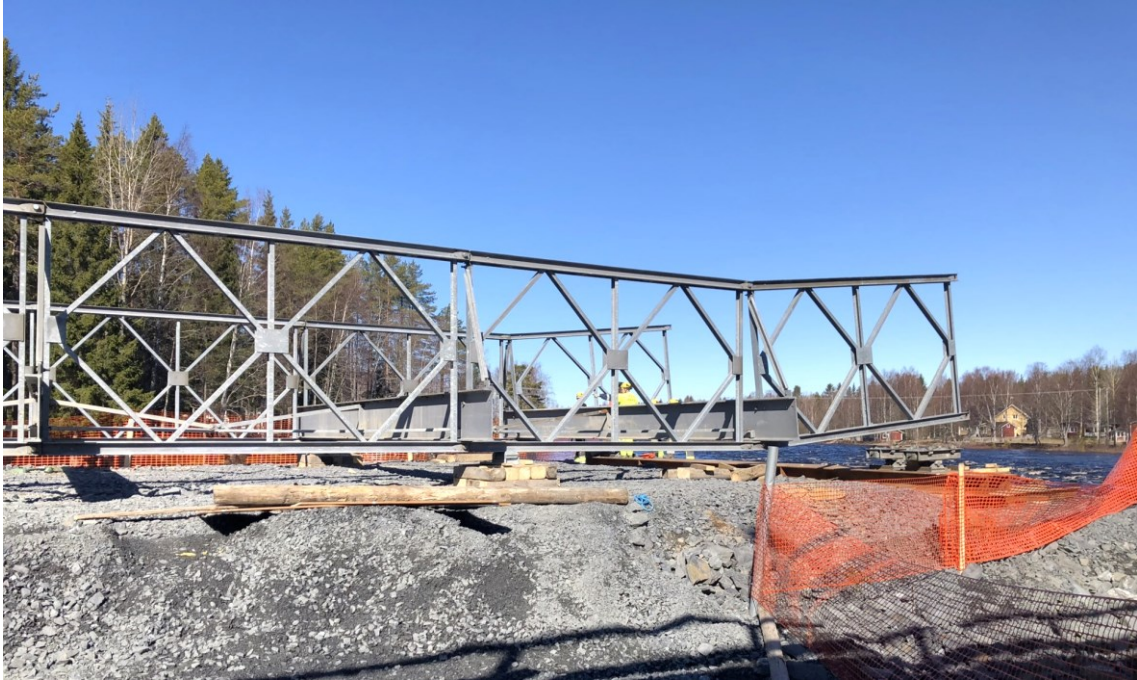
KUVA 18. Asennusnokan kärki kohotettuna kiilakappaleiden avulla
