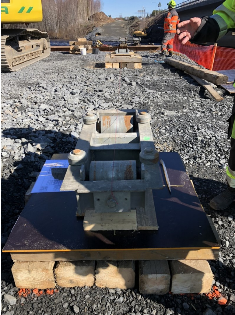
KUVA 12. Linjalanka kulki maatuen tukirullilta asennuksen tukirullille tukirullien keskilinjaa pitkin
