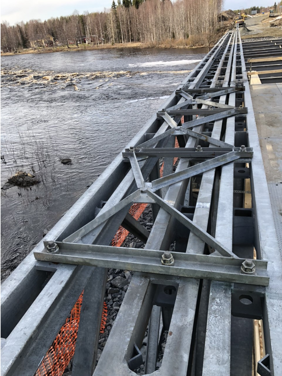
KUVA 23. Kehäelementeissä MU 125 sidekehät asennettiin yläpaarteiden yläpintaan
