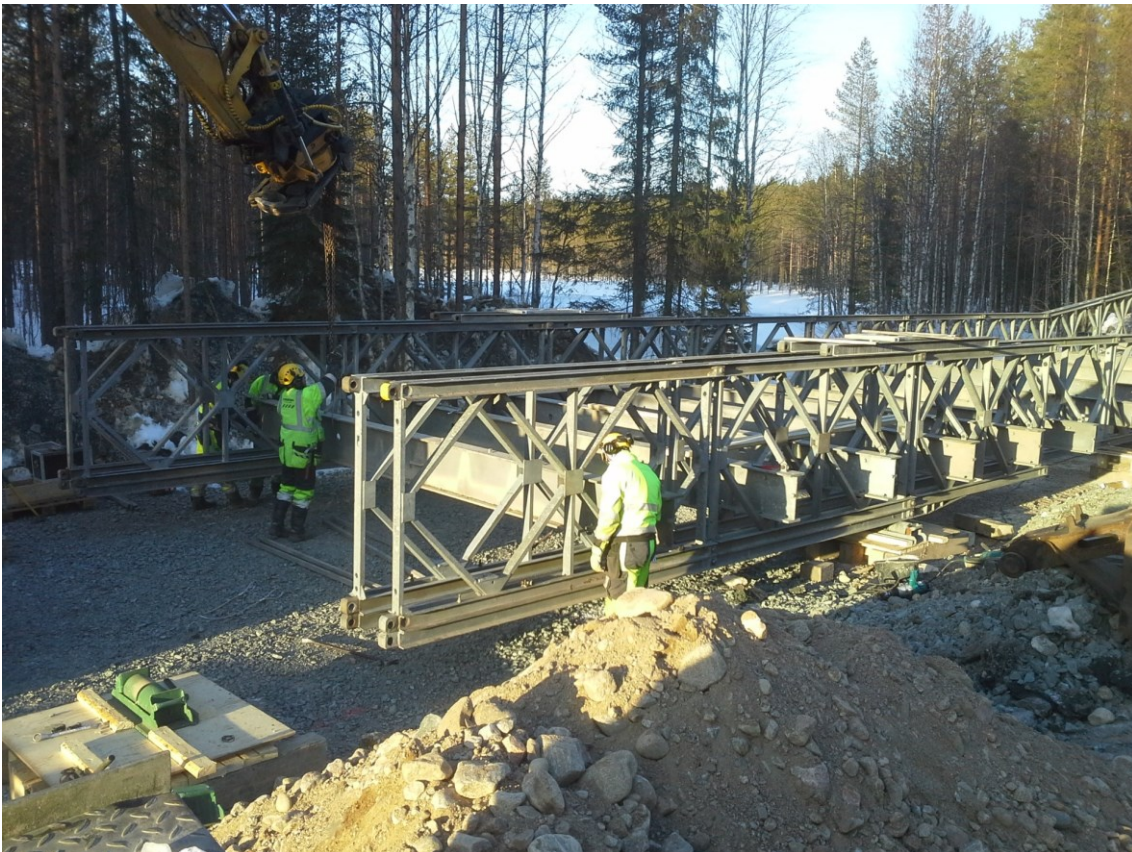
KUVA 1. Paarrevahvistettu Acrow Panel -varasilta (3)
