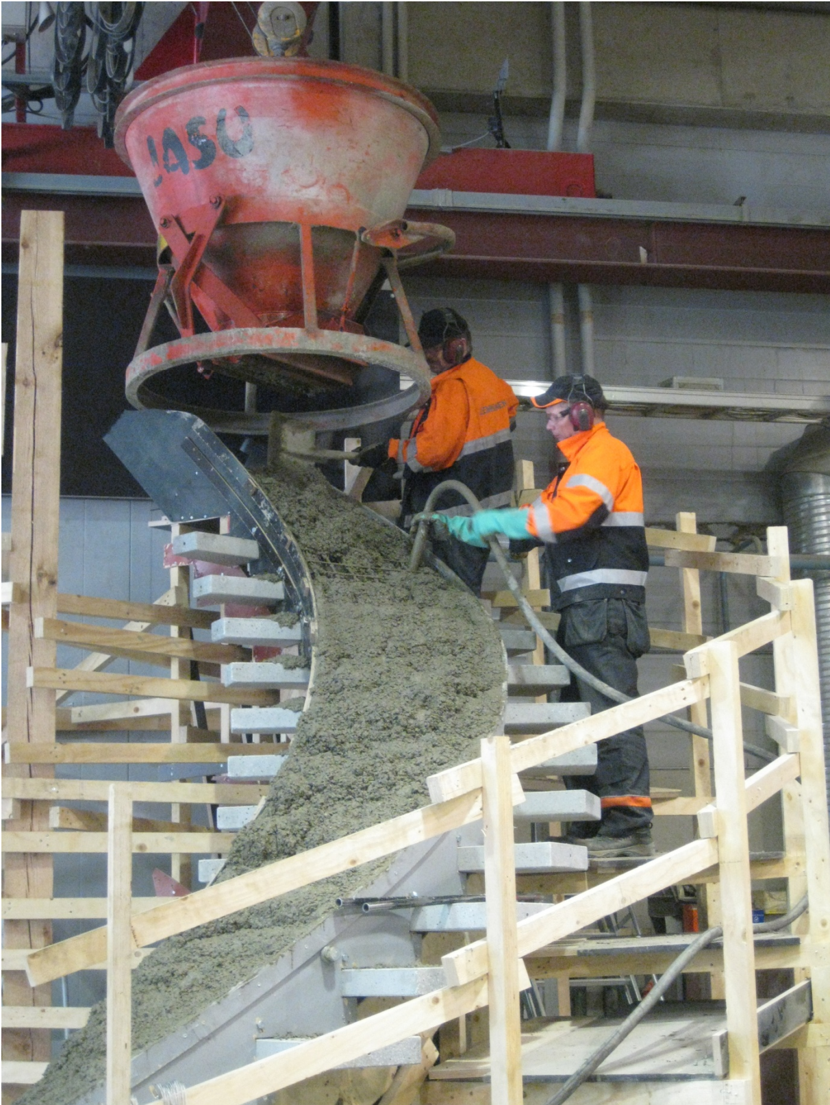
Kuva 14. Tarmo Varvia ja Ari Niemi valamassa runkoa. (kuva: Sami Hellberg )
