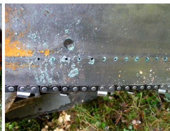
Figur 10. Urean kristalliserar i hålen. Foto JT.
