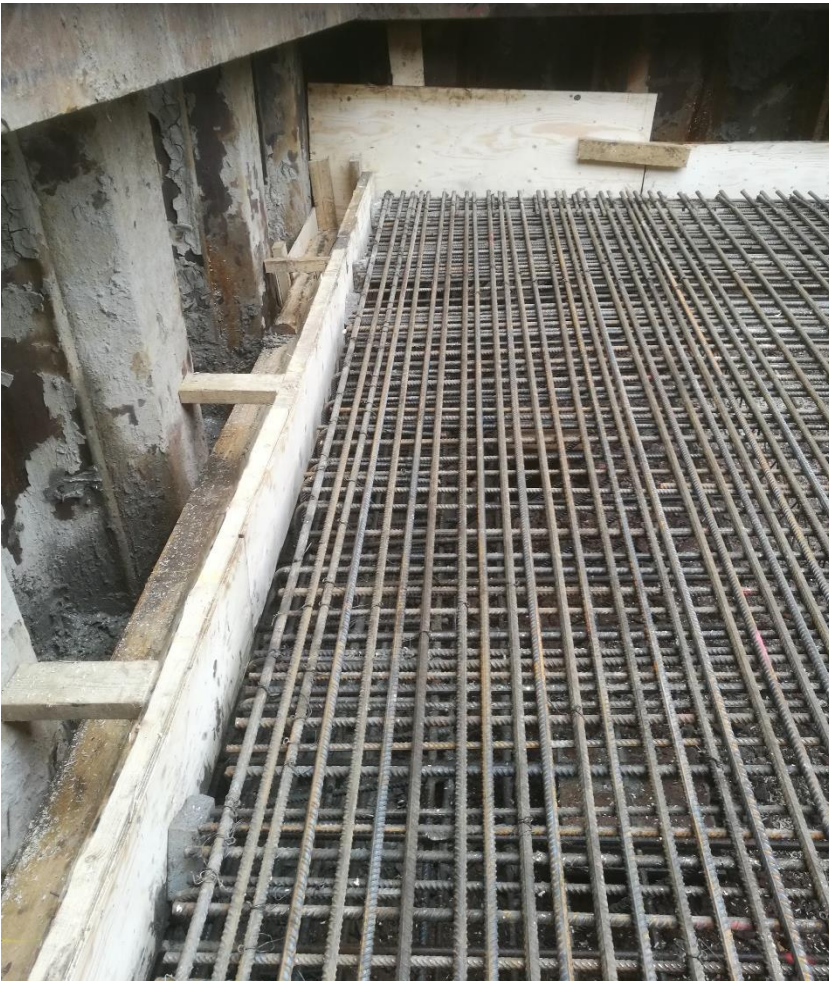
Kuva 19. Paalulaatan päädyn tuenta.
