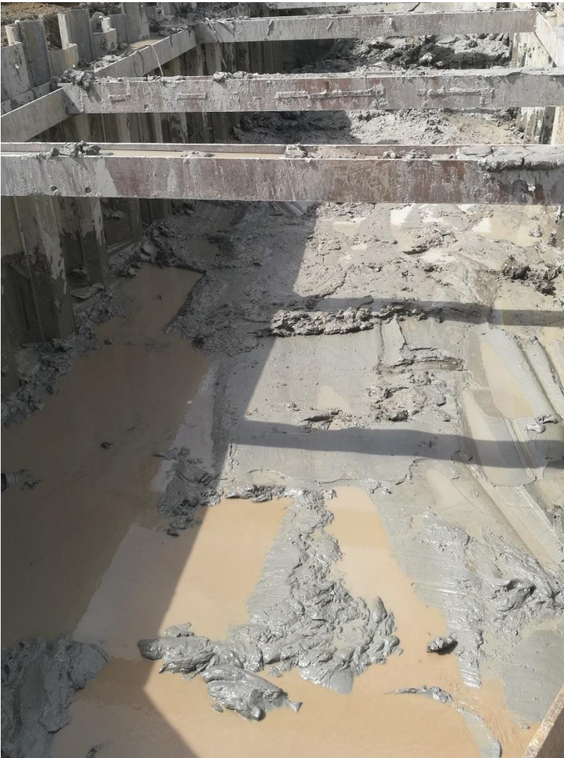
Kuva 12. Paalulaatan leikkuupohjan kaivaminen.
