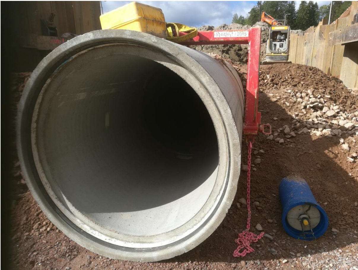
Kuva 25. Kona-asennuslaitteen vastalaitte seuraavaa liitosta varten valmiina.
