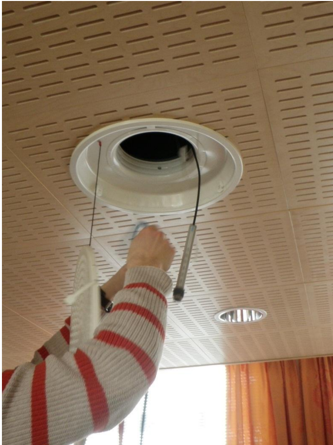
Kuva 9. Ilmamäärän mittaus TAK-liitäntälaatikosta.
