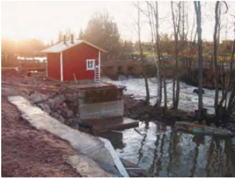
Kuva 7 Eurakosken uudistettu 84 kW voimalaitos valmiina joulukuussa 2006 (Pienvesivoimaopas 2009)
