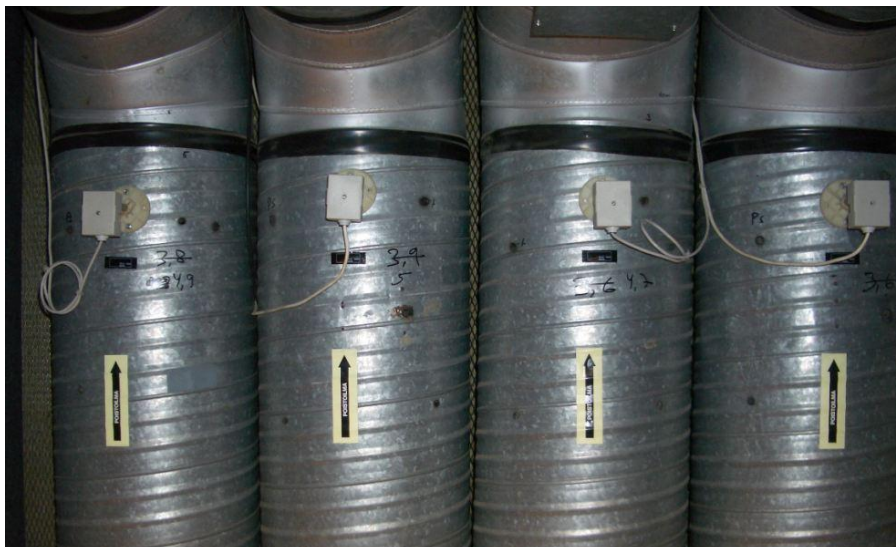
Kuva 13 Lämpötila-antureita poistoilmakanavissa.
