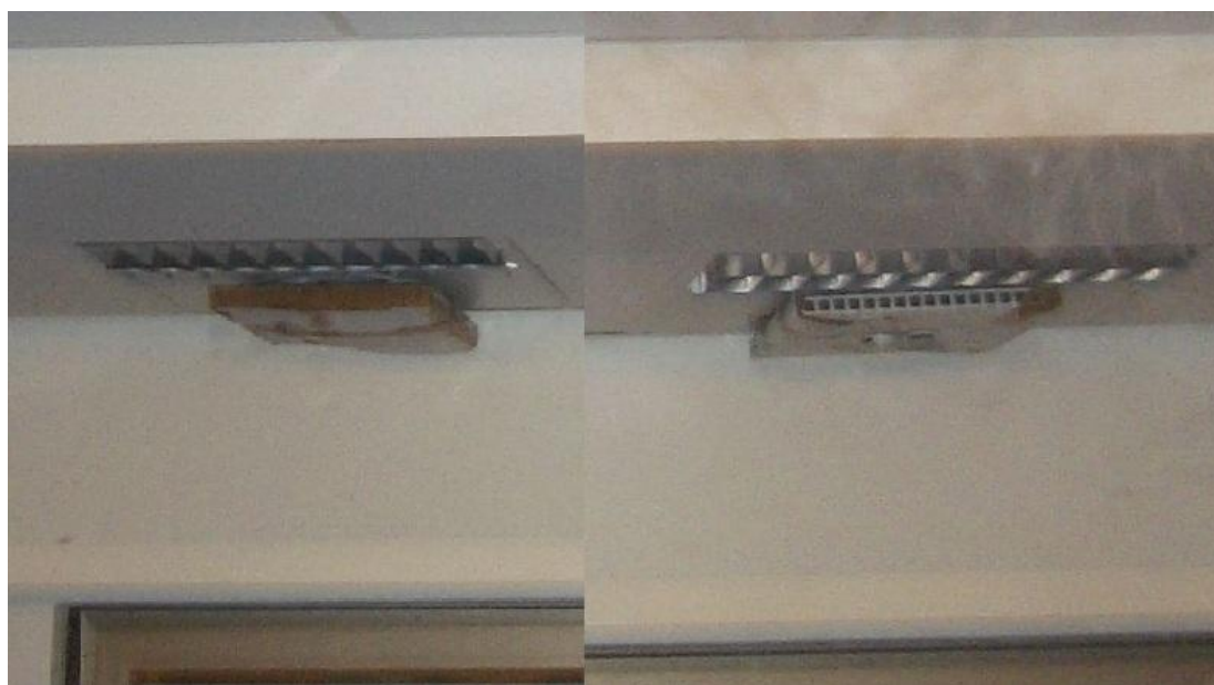
Kuva 10 Teipattu ja paperilla viritetty tuloilman päätelaite.
