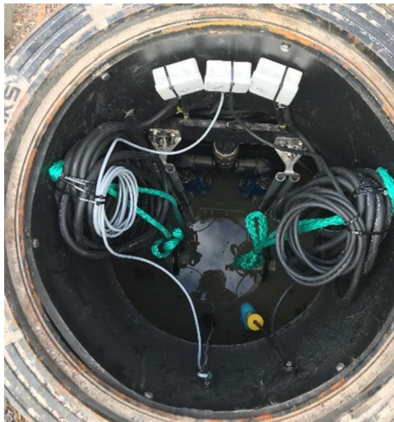
Kuva 15. Kytchentärsioiden ja ylimääräisten kaapeleiden kiinnitys teleskooppiosaan.
