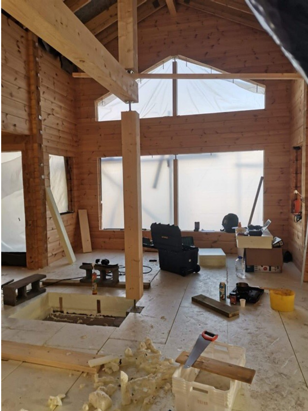
Kuva 9. Ikkuna-aukoissa suojamuovit odottamassa ikkunoiden saapumista.
