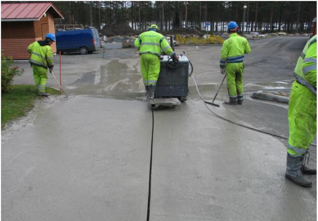
KUVA 2. Kaapelikanavan sahaaminen mikro-ojitustekniikkaa käyttäen.
