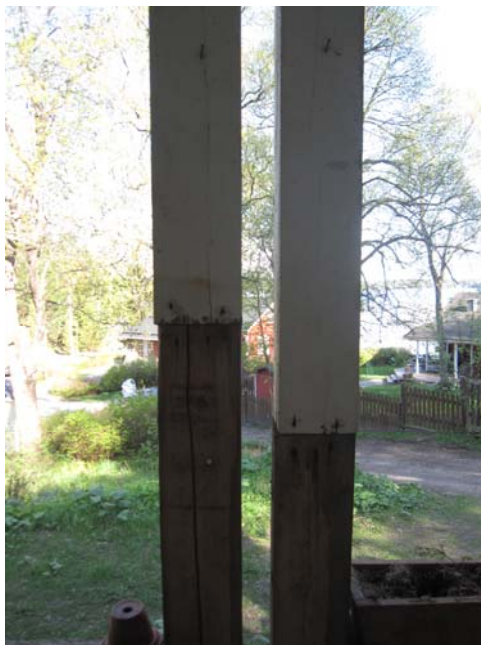
KUVA 24 Etukuistin korjatut pilarit
