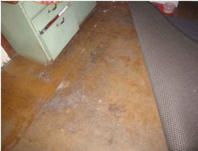
KUVA 14 Keittiön lastulevyrakenteinen lattia
