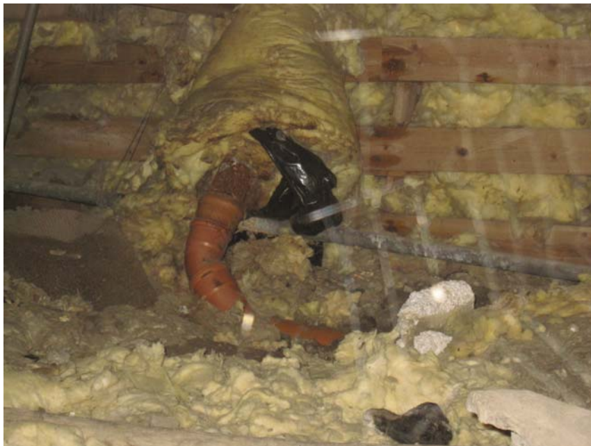
KUVA 29: Keittiön viemäri alapohjassa
