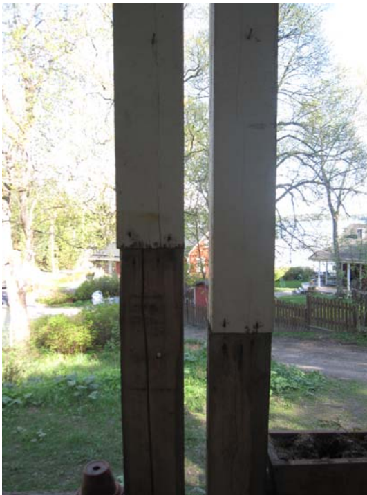
KUVA 25: Etukuistin pilareihin tehdyt korjaukset
