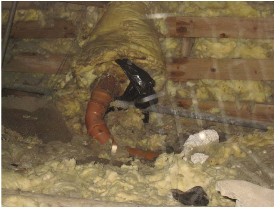
KUVA 17 Keittiön viemäri alapohjassa
