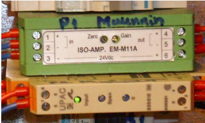
Kuva 21. Virranmittauksen mittamuuntimet.
