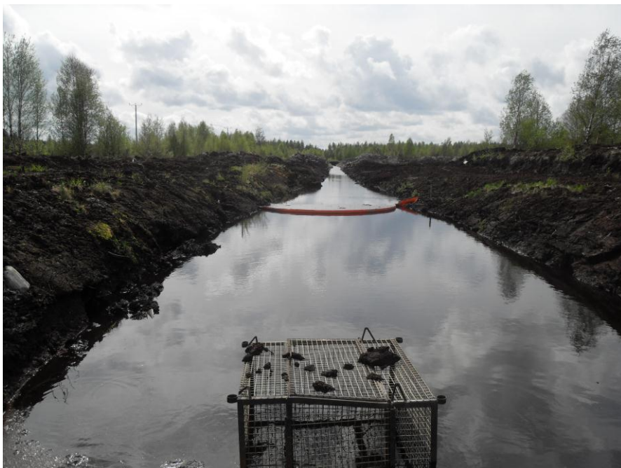
Kuva 3. Laskeutusallas ja veden purkupäässä oleva patorakenne. (Kuva: Merja Koponen.)
