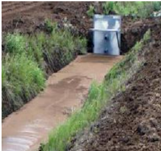
Kuva 5. Putkipato sarkaojassa. (Kuva: Merja Koponen.)
