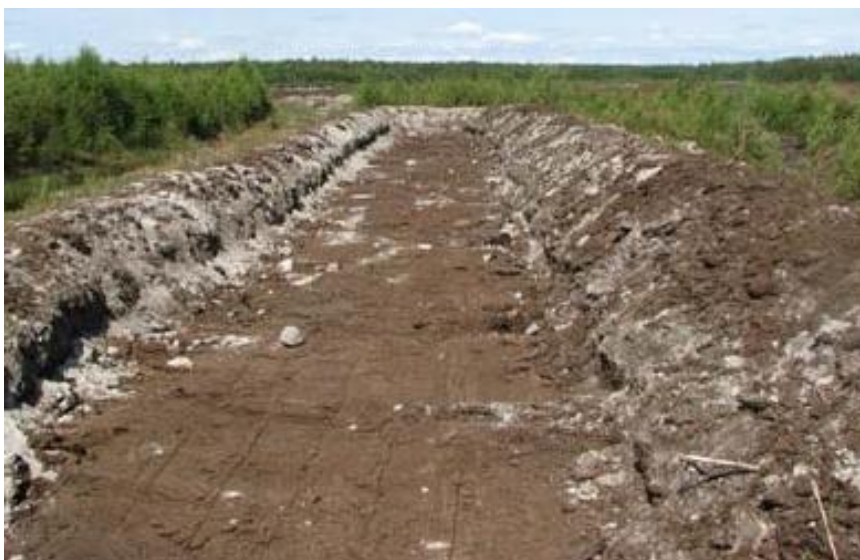
Kuva 4. Laskeutusaltaan viereen rakennettu läjitysallas. (Kuva: Merja Koponen.)
