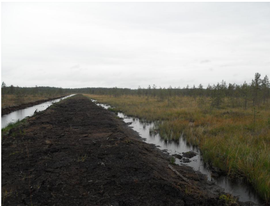
Kuva 2. Eristysoja erotettuna penkereellä pintavalutuskentästä. (Kuva: Merja Koponen.)
