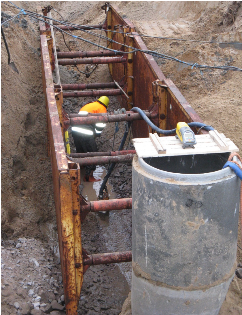
KUVA 4. Elementtiseinien käyttöä ahtaissa paikoissa
