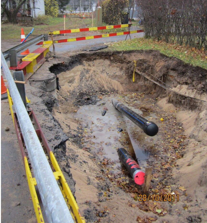
KUVA3. Suuntaporauksella asennettuja putkia
