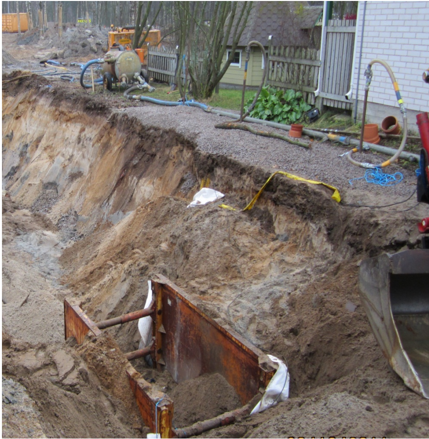
KUVA 5. Pohjaveden alennuskaluston käyttöä
