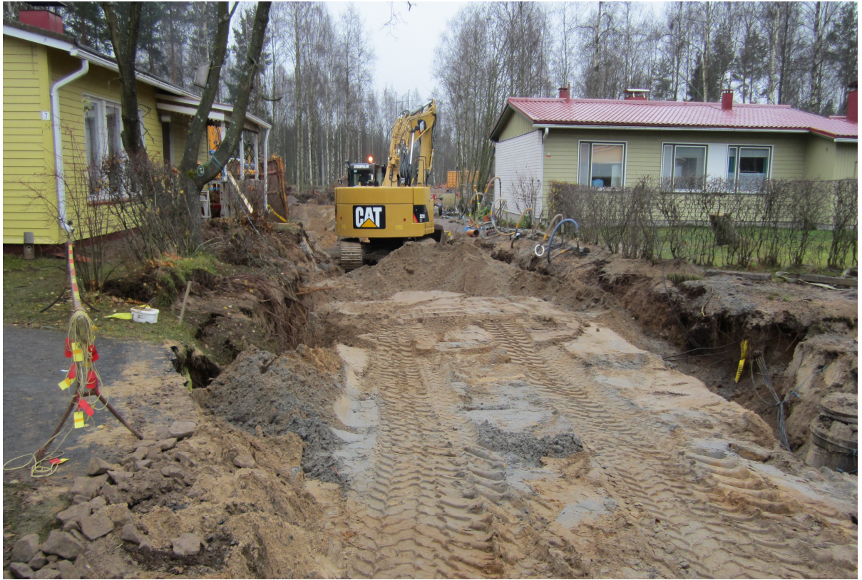
KUVA 2. Työskentelyä rakennusten läheisyydessä
