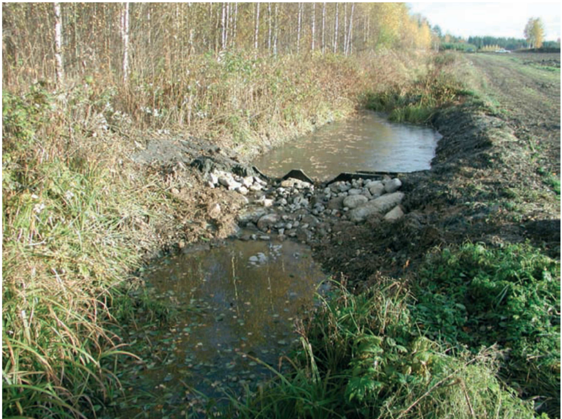
Kuva 1. Vanerilevystä ja kivistä rakennettu pohjapato ojassa.
