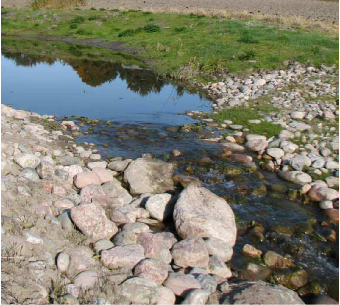
Kuva 4. Tyypillinen kivistä rakennettu pohjapato.
