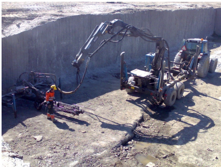
Kuva 3. Kamin pohjareikien porausta.
