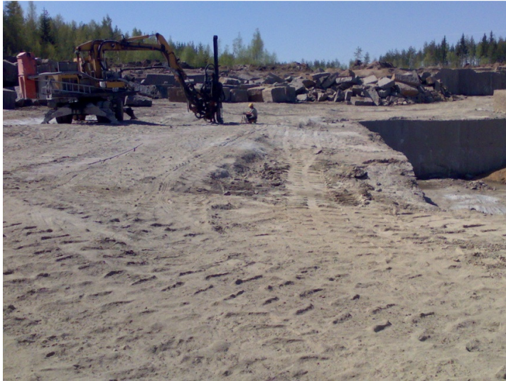
Kuva 2. Kamin selkälínjan poraus käynnissä
