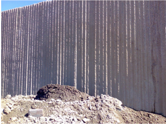
Kuva 12. Railonporauksena tehtyä pintaa.
