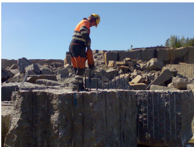
Kuva 23. Kiilojen kiristys paineilmavasaralla.
