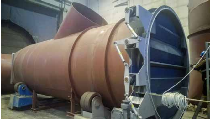
Kuva 3. Biotuotetehtaan meesauunin kanava teon alla.
