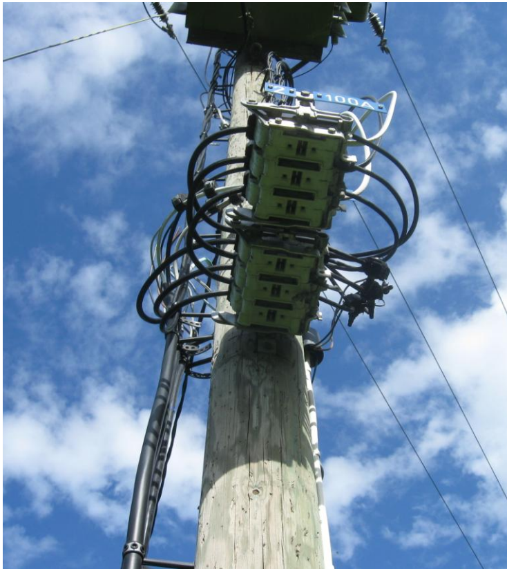
Kuva 7.4.1.2 Pylväsvarokkeet muuntamolla 27.
