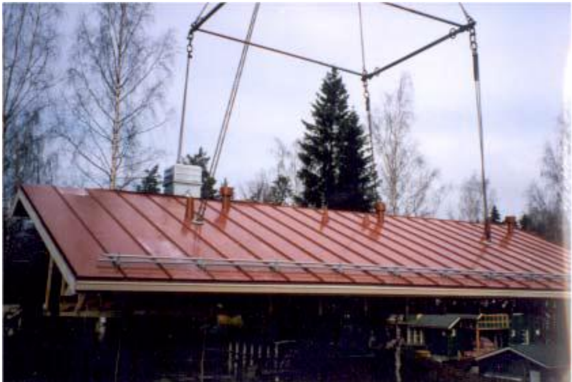
Kuvio 11. Nostokehikon käyttö [7, s. 32].
