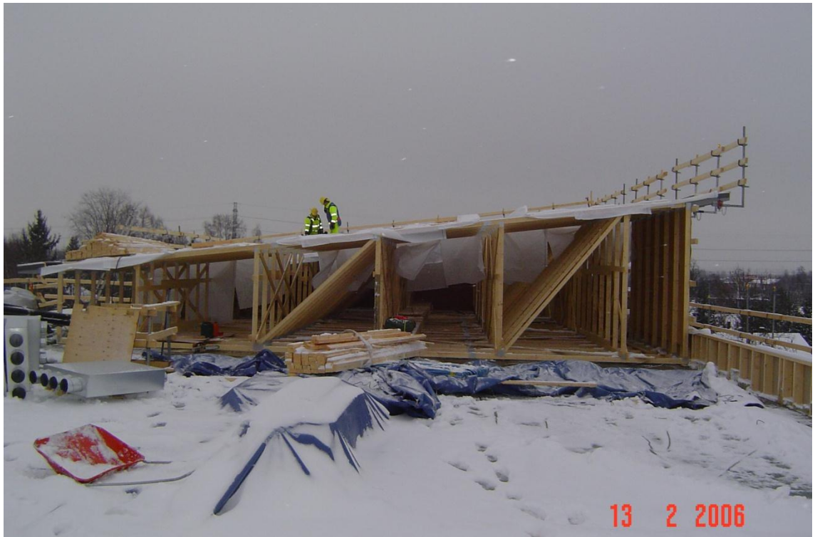
Kuvio 5. Massiivinen kattolohko, As Oy Vantaan Tammistontarha [2].
