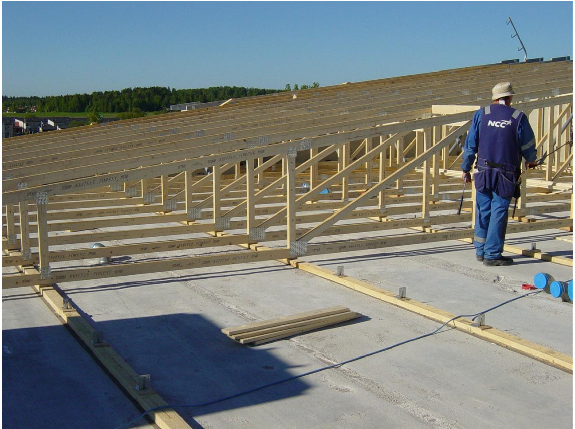
Kuvio 3. Kattoristikoiden asennus perinteisellä menetelmällä, As Oy Tammistonkatu 33.
