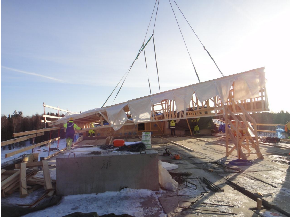
Kuvio 8. Lohkon asennus, As Oy Helsingin Helleranta.
