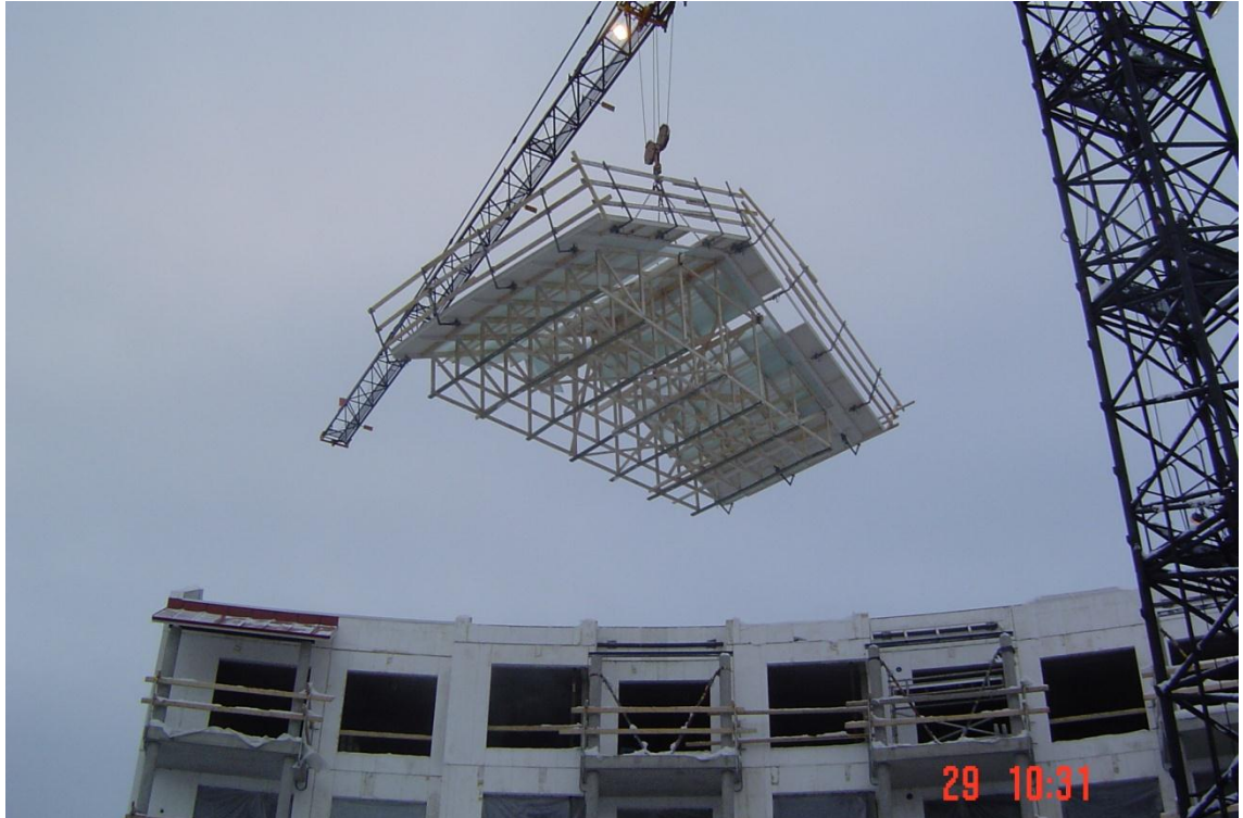
Kuvio 1. Kattolohkon nosto, As Oy Vantaan Vouti [2].
