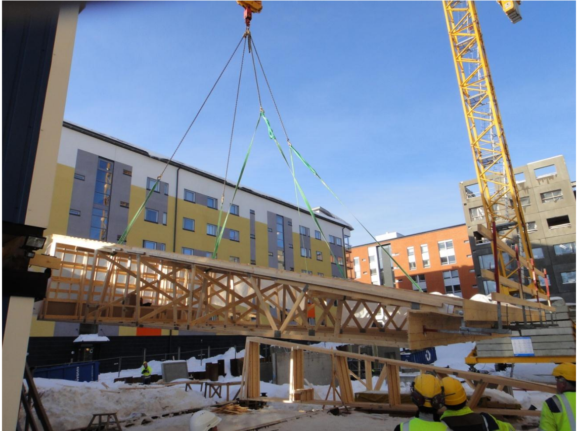
Kuvio 7. Kattolohkon koenosto, As Oy Helsingin Helleranta.
