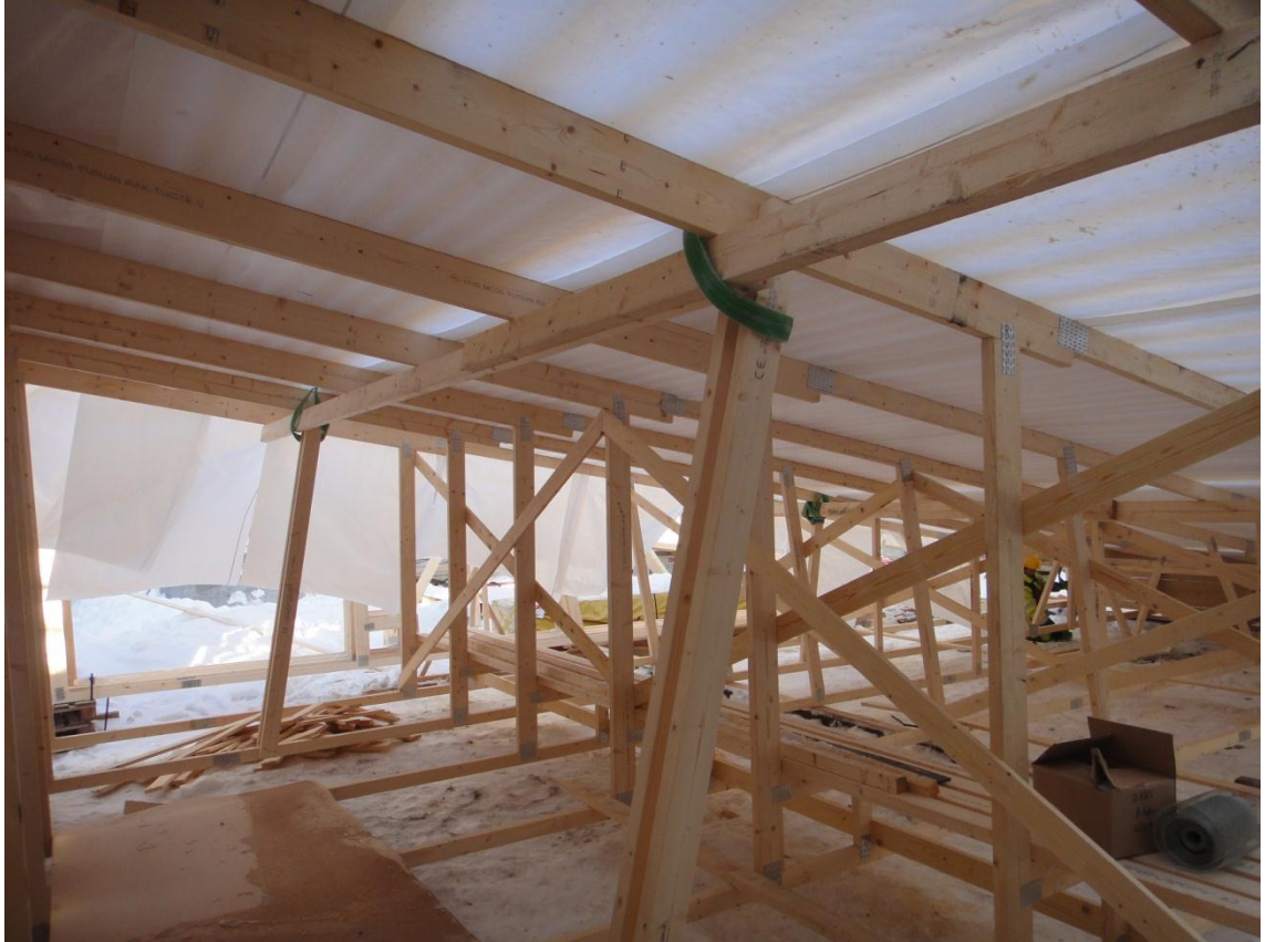
Kuvio 16. Nostopalkin pystyvahvisteita, As Oy Helsingin helleranta.
