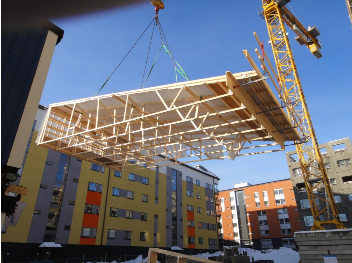
Kuvio 2. Pulpettikaton 6-pistenosto, As Oy Helsingin Helleranta.
