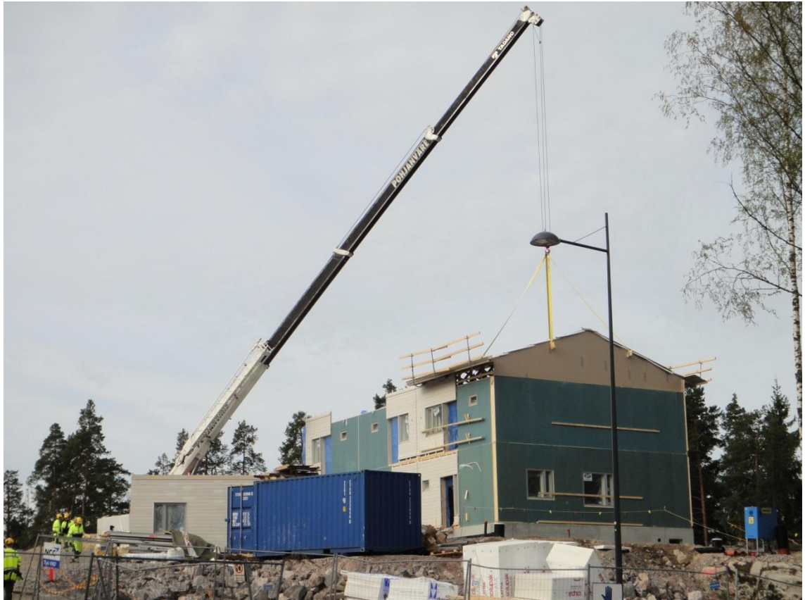
Kuvio 9. Kattolohkon asennus ajoneuvonosturilla puurakenteiseen rivitaloon, As Oy Espoon Ratasmylly.
