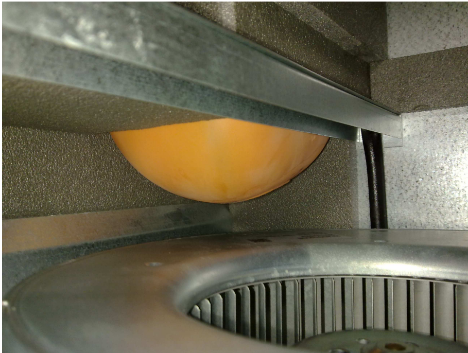
KUVA 4. Ilmanvaihtokoneen raitisilmakanava tiivistettynä lentopallon sisusku- milla
