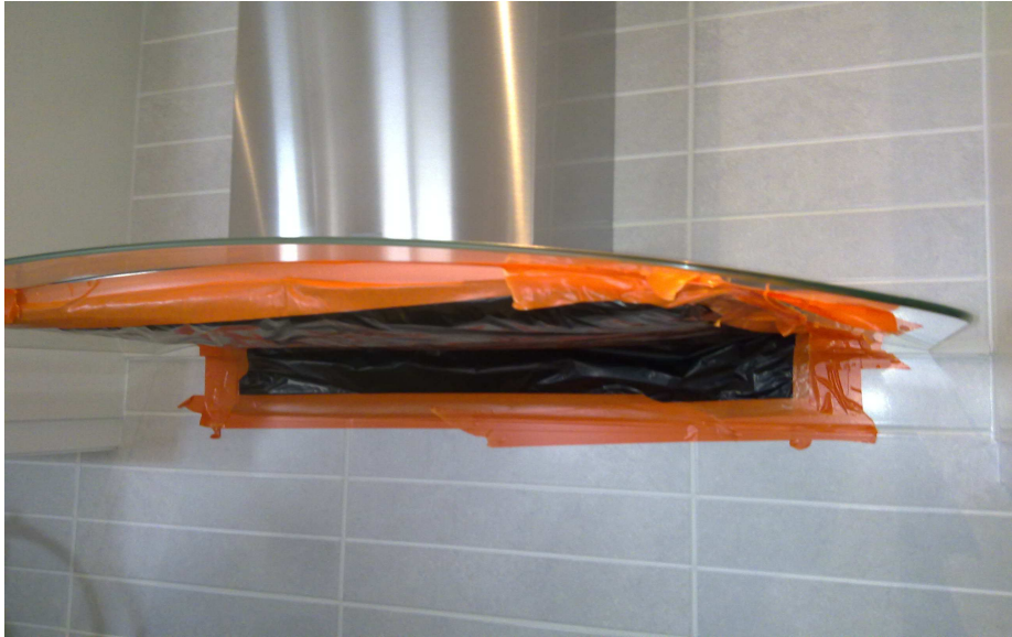
KUVA 6. Liesikupu tiivistetty muovilla
