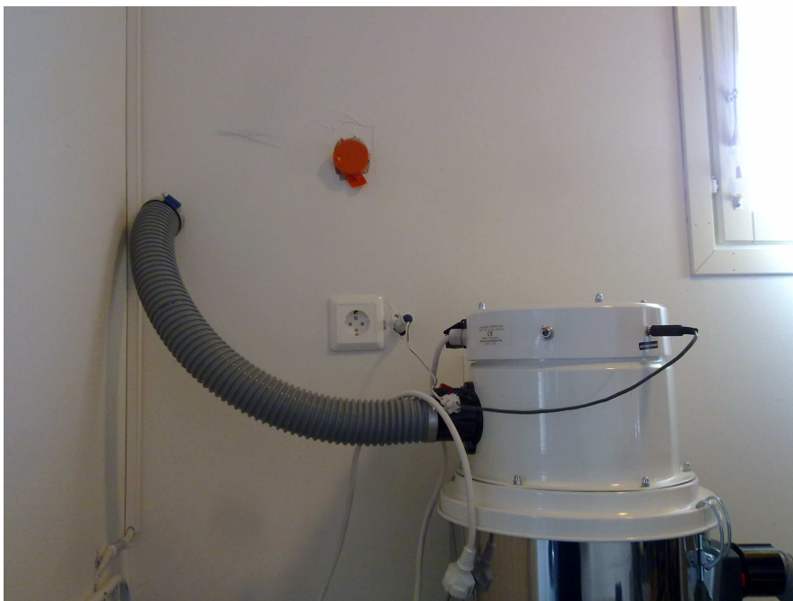
KUVA 5. Keskuspölynimurin reikä tiivistetty teipillä
