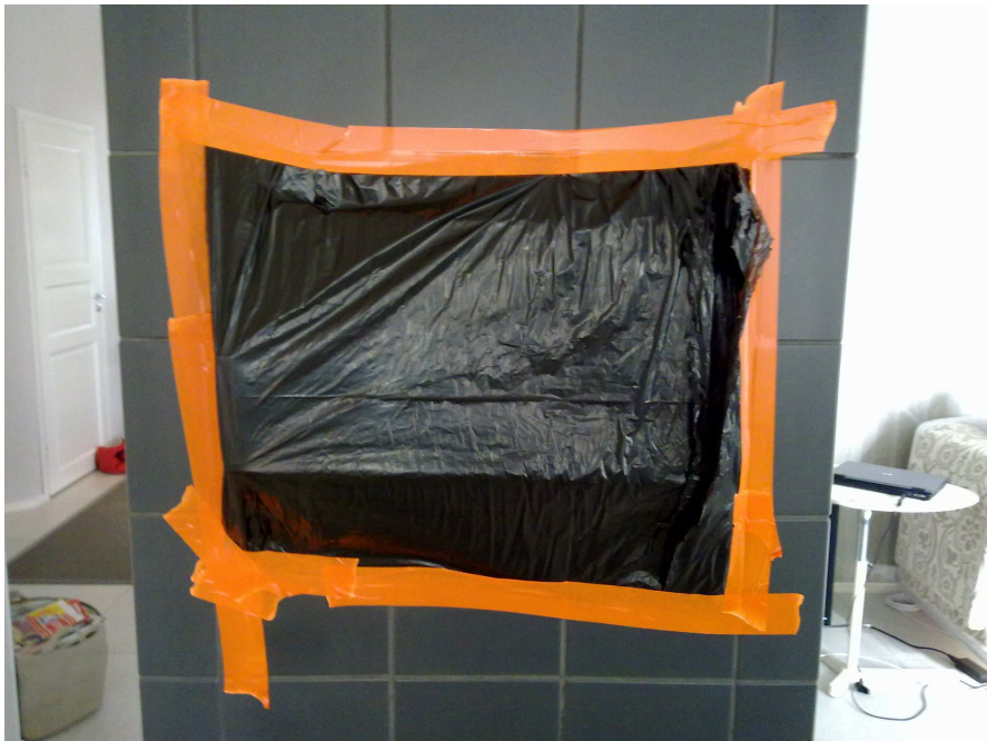
KUVA 7. Tulisijan luukut tiivistettynä jätessäkillä
