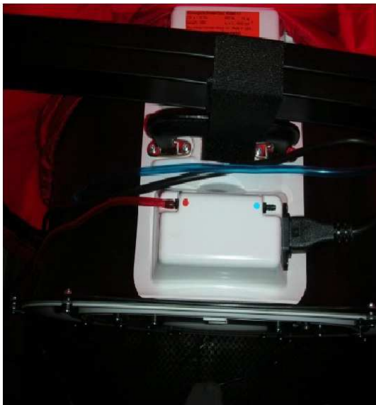
KUVA 13. Letkuyhteet puhaltimen päällä
