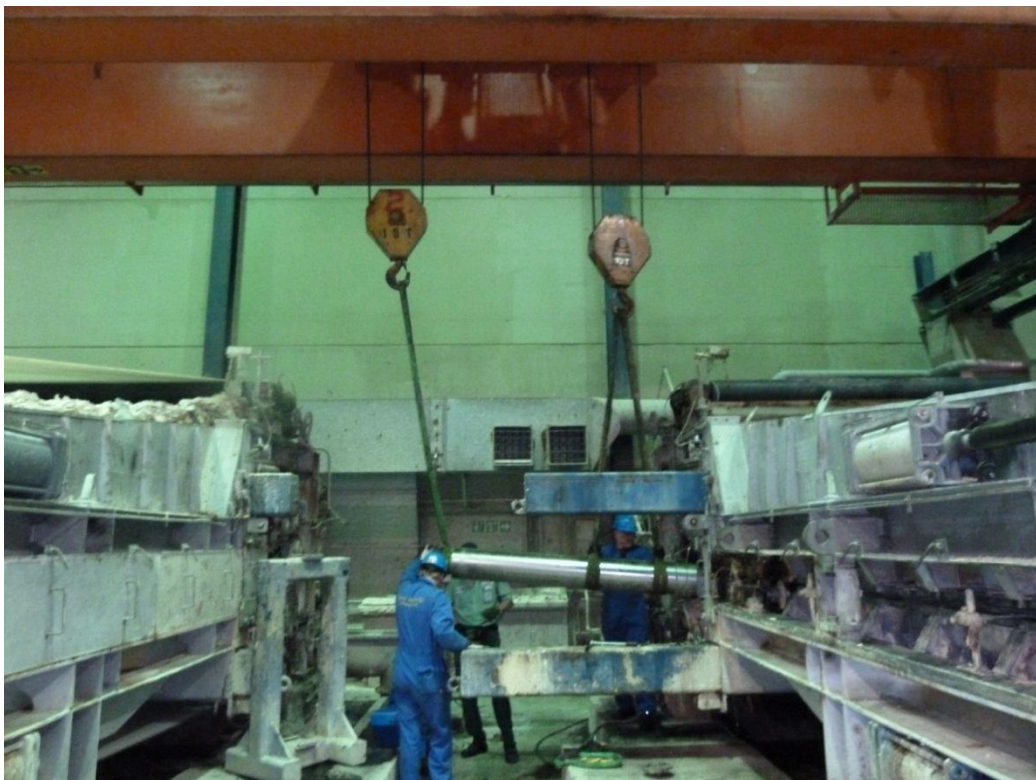
Kuva 6.7 Nosto suoritetaan enää toiselta puolelta, mutta kahdella nostoliinalla.
