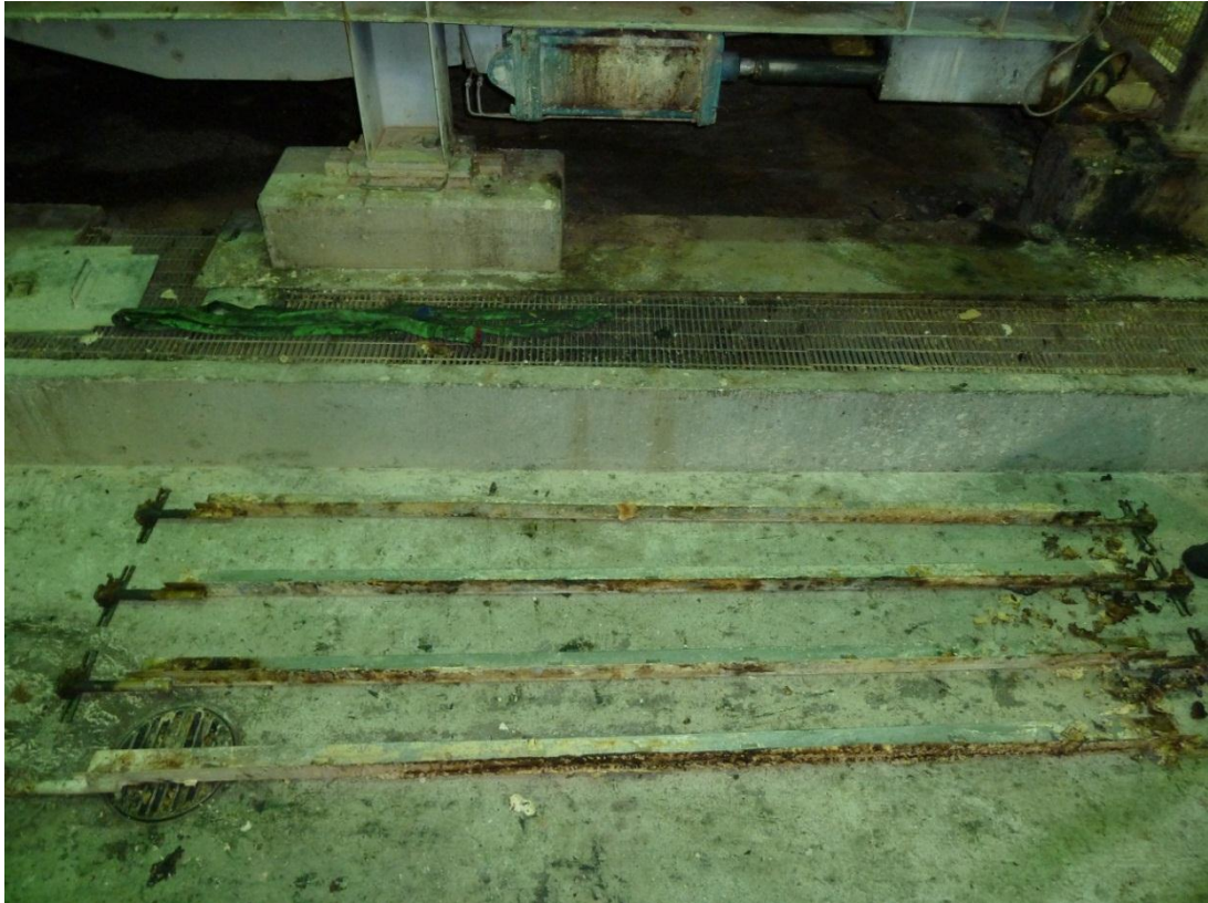
Kuva 6.11 Ylätelojen välissä olevat kaavarit
