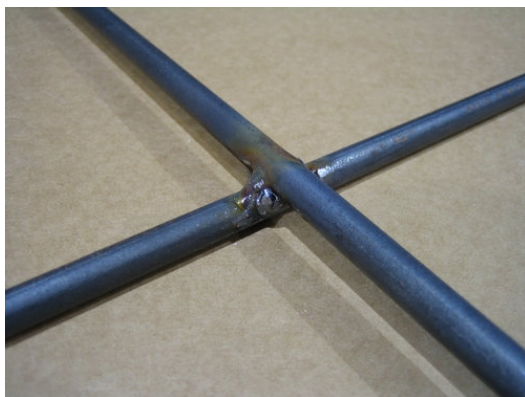
KUVA 14. Umpitanko valmis liitos.
