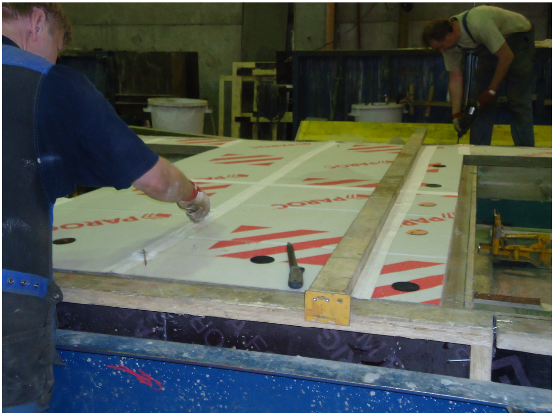
Kuva 7. Villanaulojen ja ramlojen asennus elementtitehtaalla.
