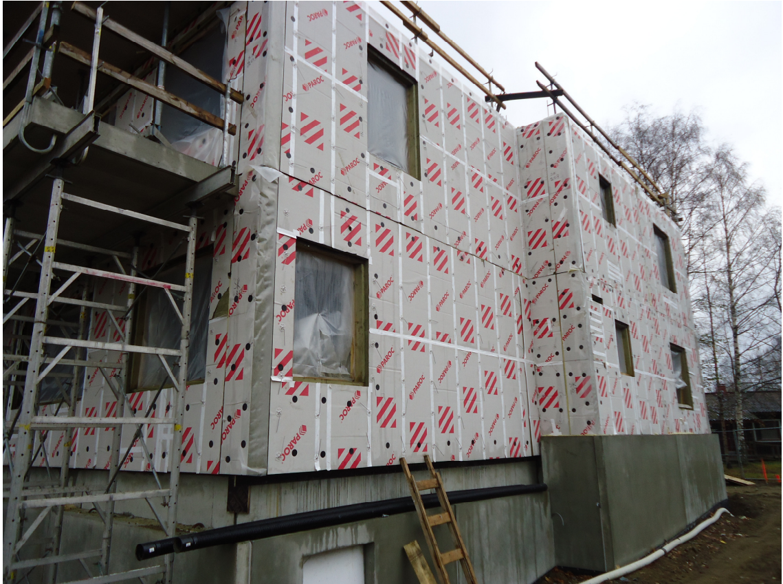
Kuva 6. Kohdekerrostalon ensimmäisen ja toisen kerroksen teräsbetoniseinäelementit tuulensuojaeristysineen asennettuina.
