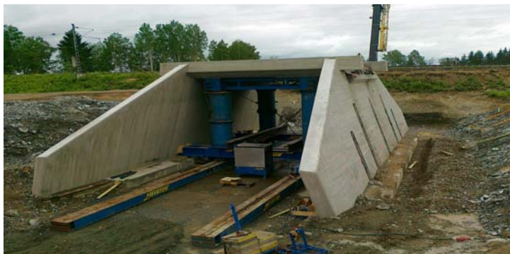
Kuva 3 Laattakehäsilan siirto tunkkaamalla.
