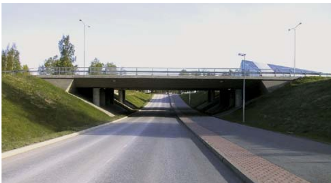
Kuva 4 Teräsbetoninen ulokelaattasilta.
