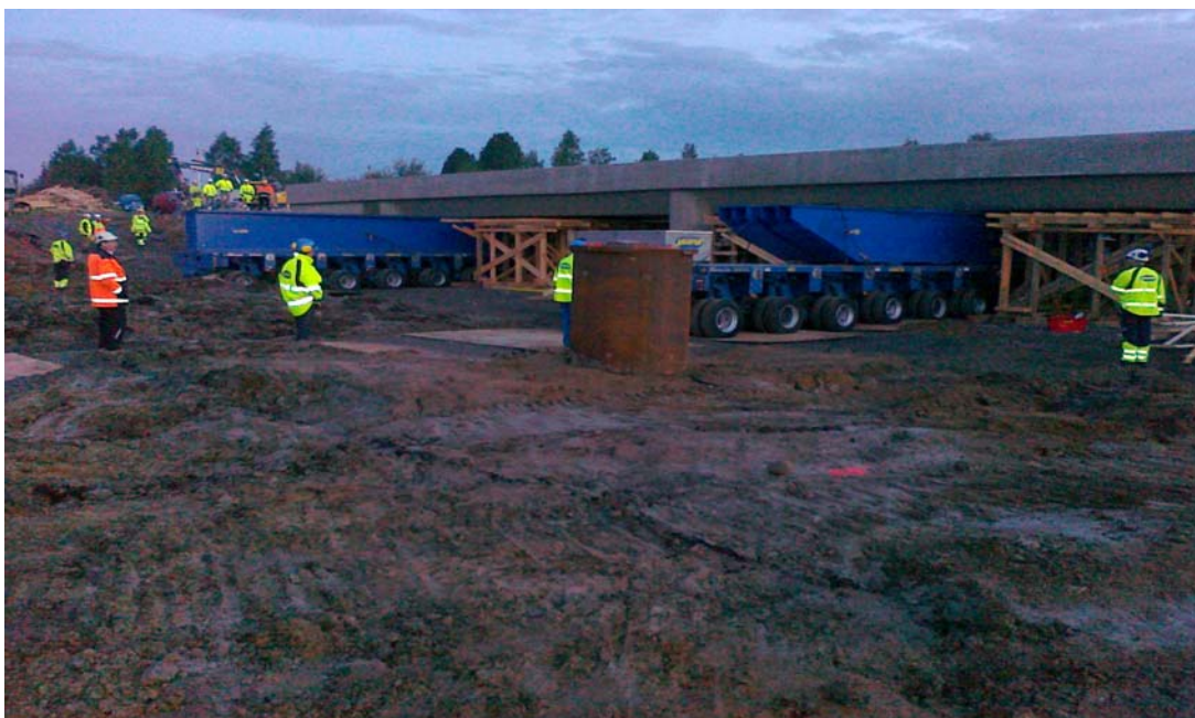
Kuva 6. SPMT-tekniikka mahdollistaa avoimemman liikumisen kohteella. (Suonteen sillan siirto 2012. Savon Kuljetus Oy.)
