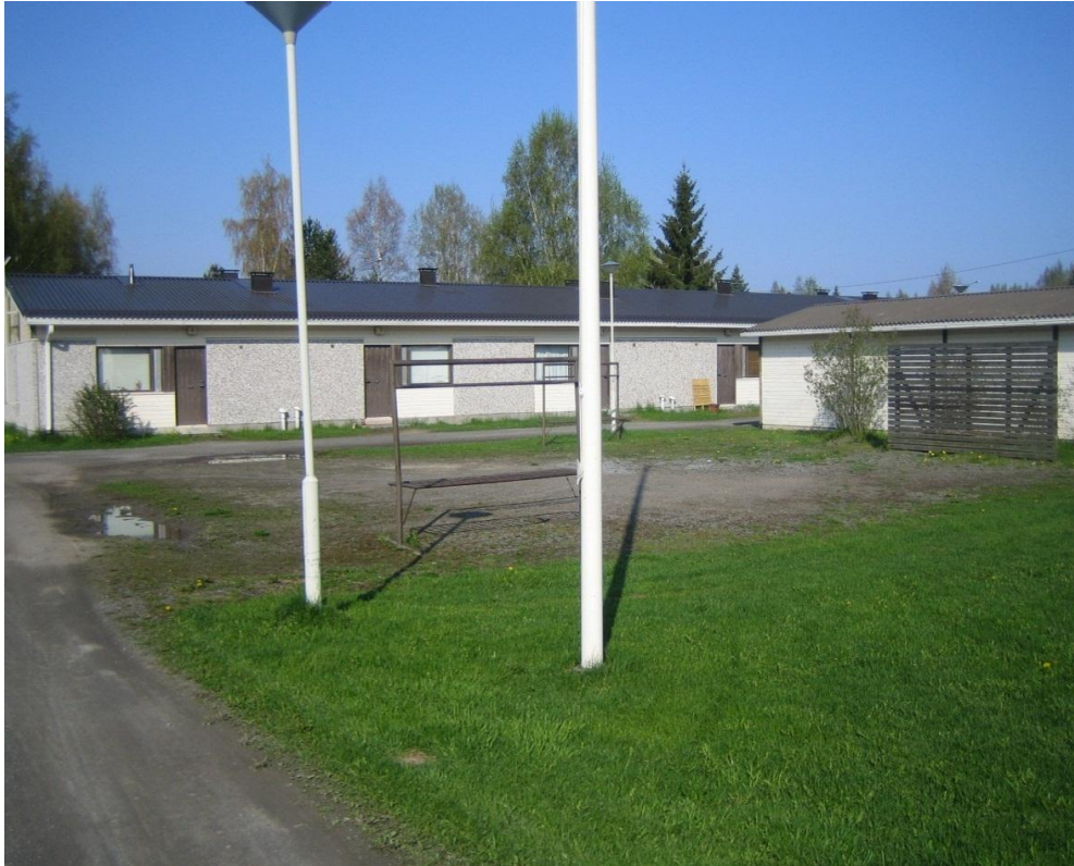
Kuva 1. Parkkialueena pidetty piha-alue. Syytä laittaa kuvassa näkyvien lätäköiden kohdille puskat.
