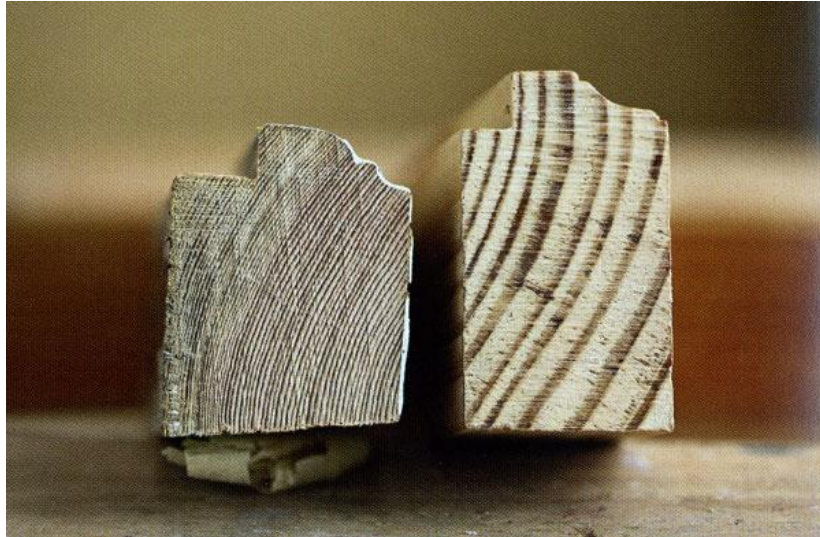
Kuva 5. Aiemmin ikkunapuitteisiin käytetty tiheäsyinen mänty on rakenteeltaan erilaista kuin nykyisin käytettävä puu (Stenbacka, A. & Stenbacka, E. 2010, 16).
