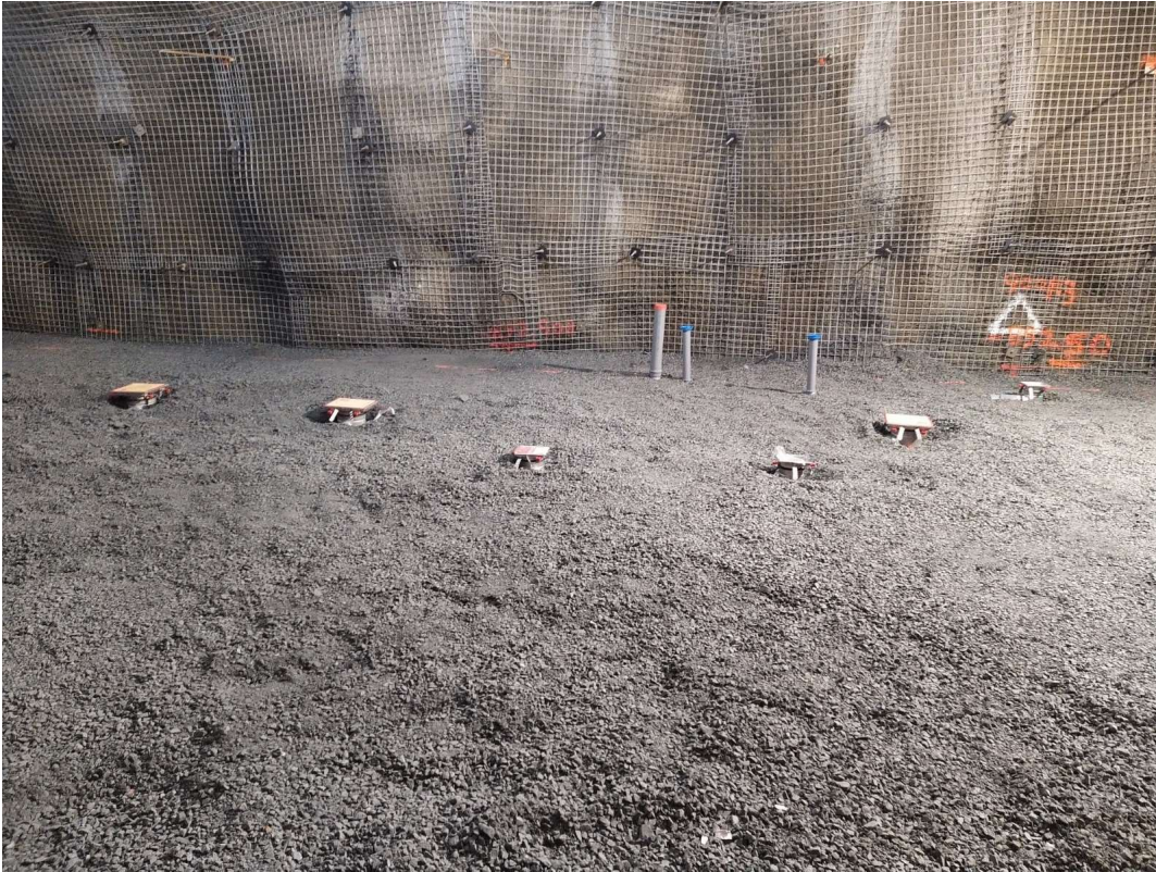
KUVA 5. Kiinteistöviemärointi maan alla.
