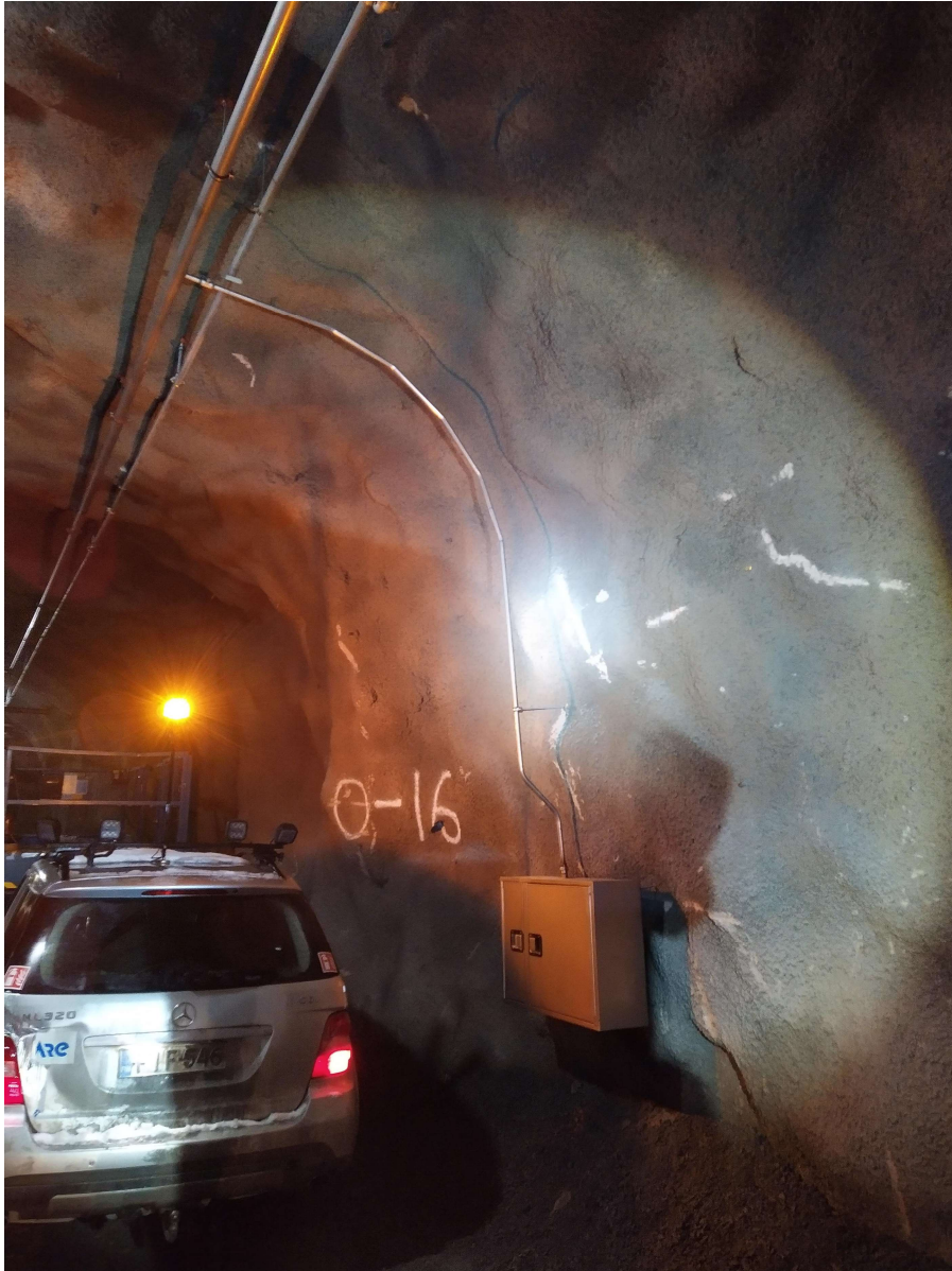
KUVA 10. Palopostikaapin malliasennus maan alla
