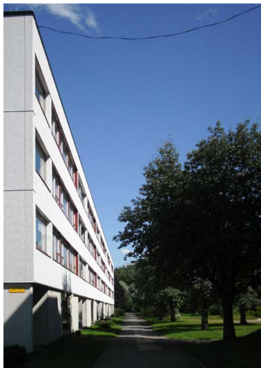
Kuva 34. Yhtenä Suikkilan arvona voidaan pitää sen arkkitehtonista yhtenäisyyttä, kuten nauhamaisia ikkuna- ja parvekelinjoja. Kuvan talo sijaitsee korttelissa 56, tontilla 1.
