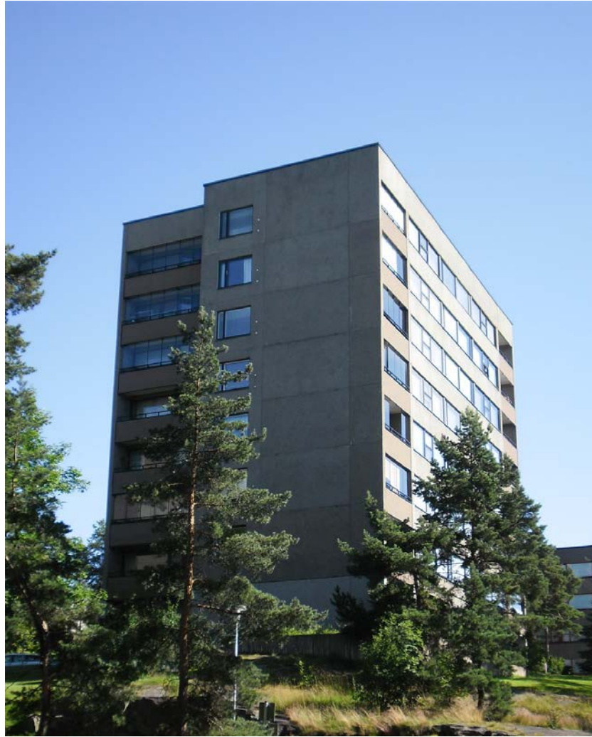
Kuva 29. Talinkorventien pistetalojen tavoin Århusinkadun talojen (kortteli 68) rakennusmassassa on porrastuksia. Väriykseltään ne ovat tummempia.
