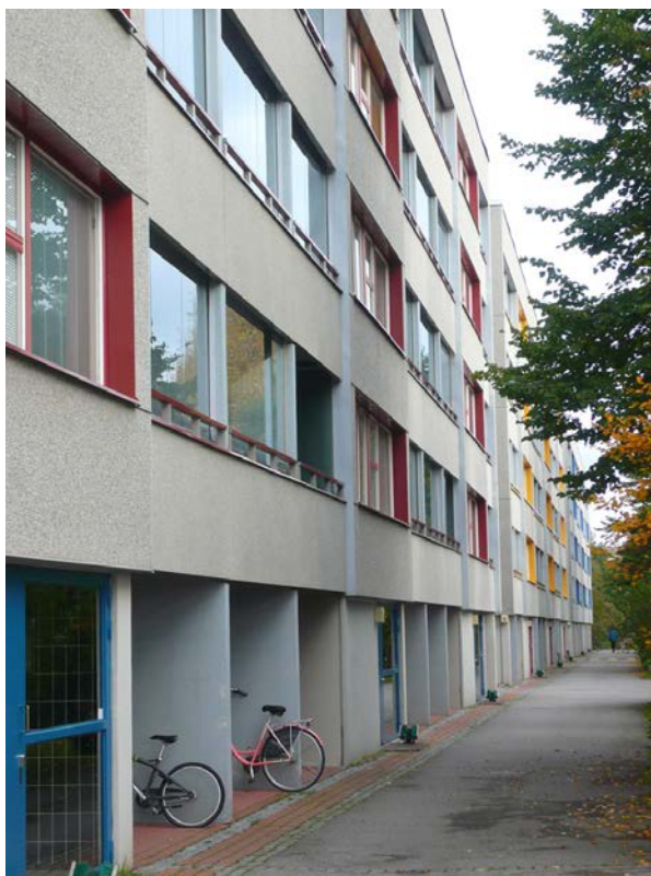
Kuva 30. Korttelin 70, tontin 8 lamellitalot on levytetty, jolloin julkisivun pinta on noussut. Tämä korostaa ikkunankehysten vaihtelevaa väritystä.
