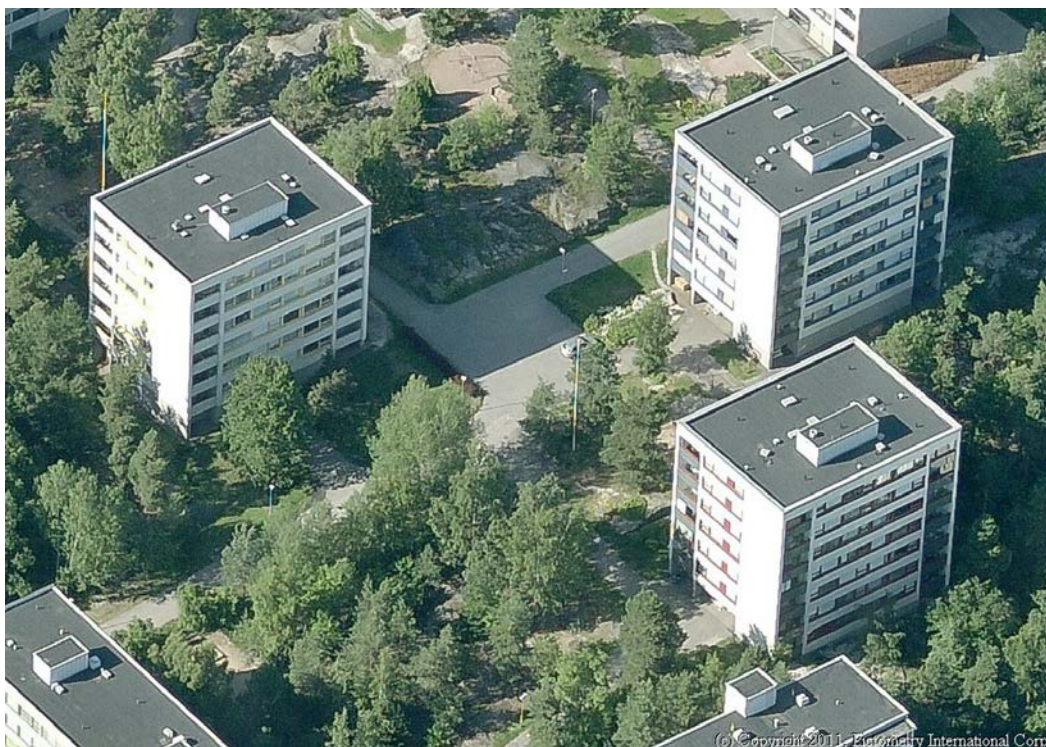
Kuva 17. Korttelin 20, tontin 2 talojen uudet, eriväriset parvekkeet ovat muuttaneet talojen ulkonäköä (oik.). Nauhamaisuus ei korostu enää niin voimakkaasti parvekkeiden muodostaessa selkeän pystylinjan. (Kuva: Blom Kartta Oy 2011.)
