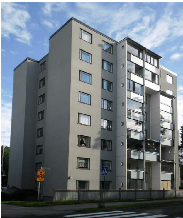
Kuva 13. Kortteleiden 1 ja 2 pistetalojen julkisivut on saneerattu, jolloin pinta on rapattu tasaiseksi ja ikkunat vaihdettu uusiin. Kuvan talo sijaitsee korttelissa 2, tontilla 2.
