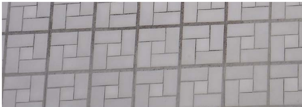
Kuva 19. Sarainmaan suunnitteleminen kortteleiden 17, 18, 22 ja 23 talot on verhoiltu keraamisella laattalla, jossa on nähtävissä pieniä yksityiskohtia.
