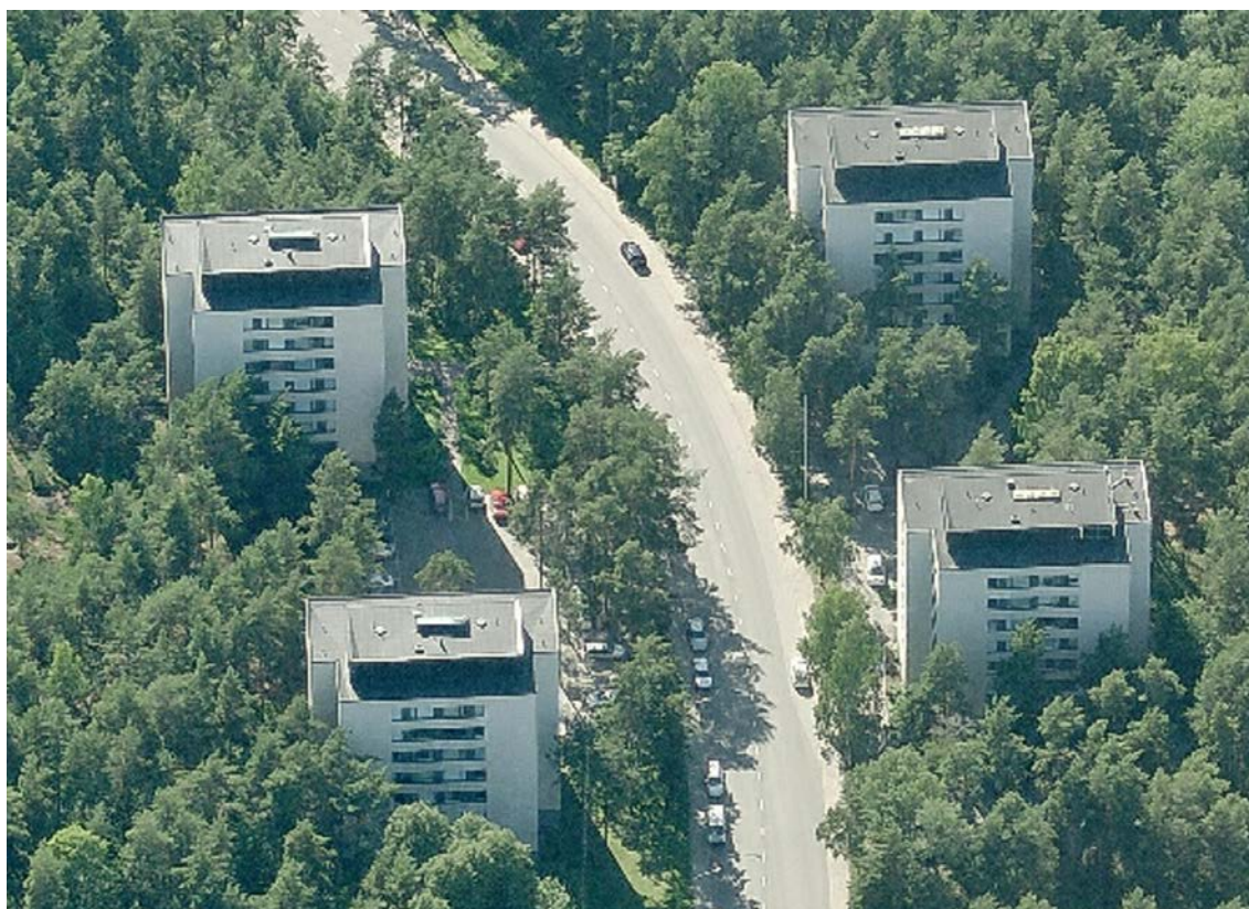
Kuva 27. Talinkorventien varrelle sijoituviissa pistetaloissa on Pitkäsen suunnittelulle tyypilliset nauhaikkunat ja 1960-luvulle ominaisesti vaalea julkisivu ja tummat ikkunankehukset. Rakennusmassa on vahvasti porrastettu (vas. kortteli 50, tontti 1; oik. kortteli 49, tontti 2). (Kuva: Blom Kartta Oy 2011.)
