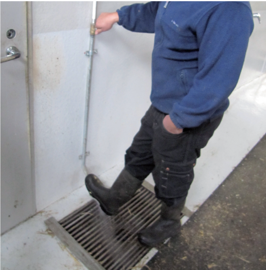
Kuvio 4.1. Vesiputki on taivutettu noin 17 cm korkeudelta lattiasta. Litistetty putken pää lisää veden painetta, mikä säästää vettä ja parantaa lian poistamista.
