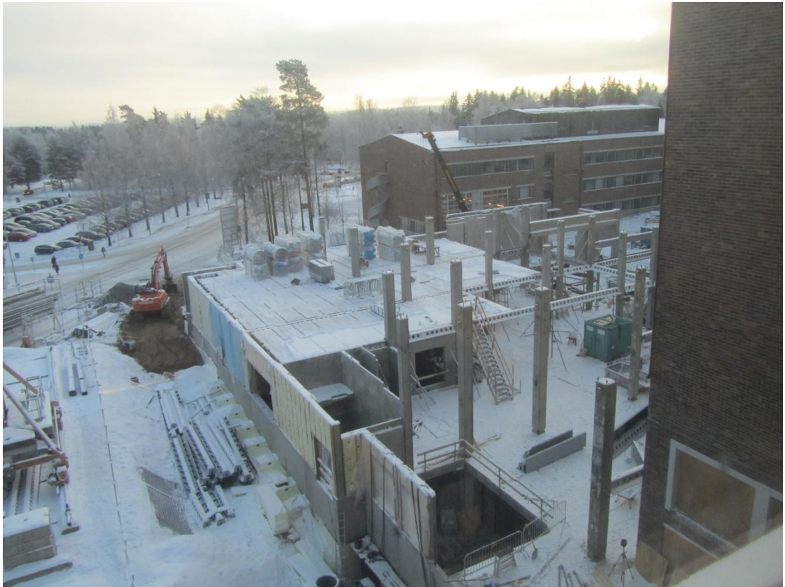
Kuva 27. Työmaa on aloitettu elokuussa. Kuva on otettu 9.1.2012.
