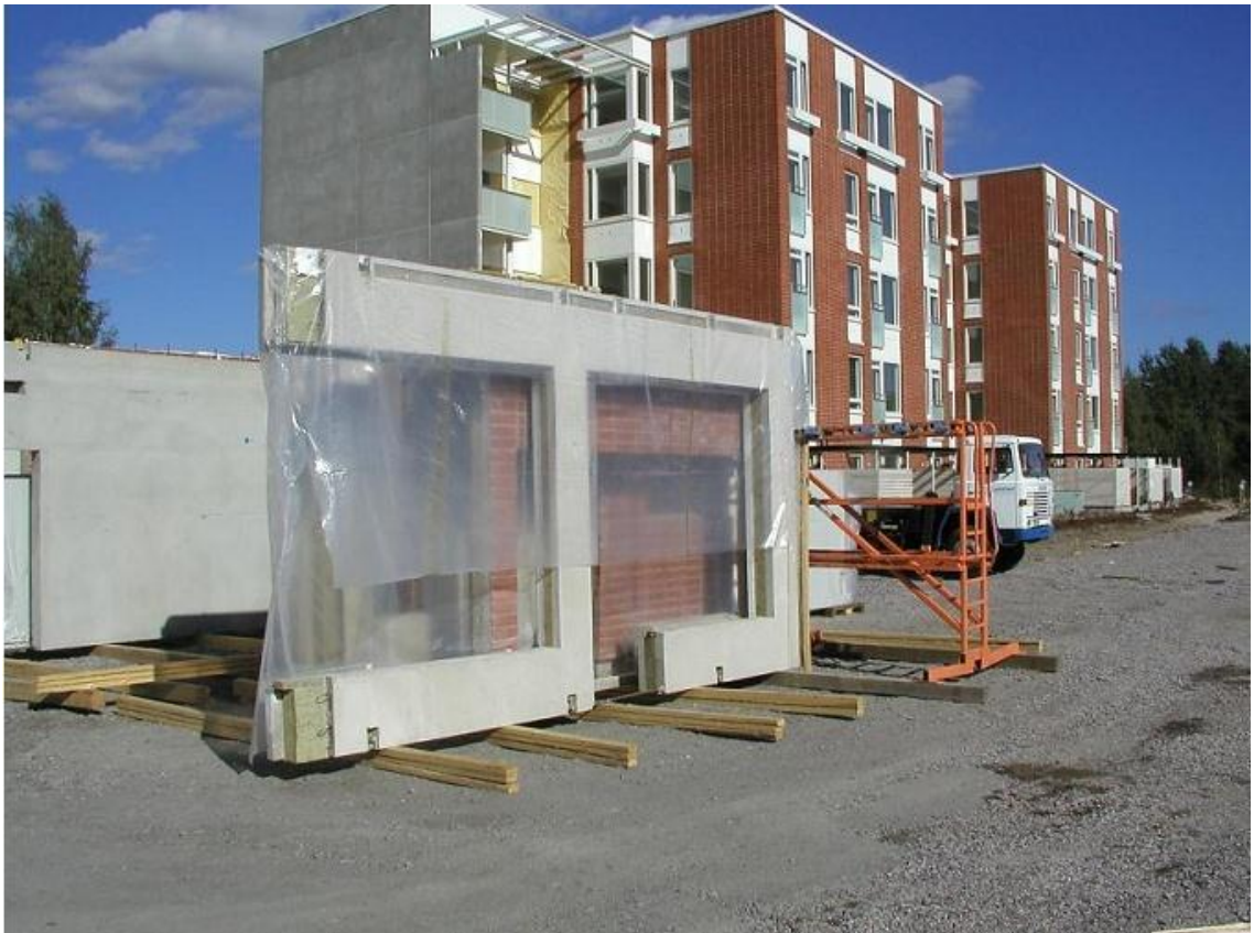
Kuva 1. Seinäelementti (VTT:n rakennus- ja yhdyskuntatekniikka)
