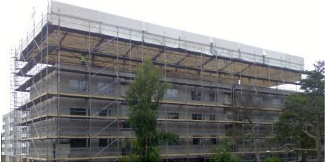
Kuva 19. Alumiini telineiden varaan rakennettu vesikaton suojaava rakennelma. (P. Tolvanen. 2011, s.22)
