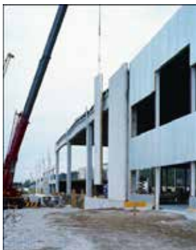
Kuva Teollisuusrakennuksen runkojärjestelmä
