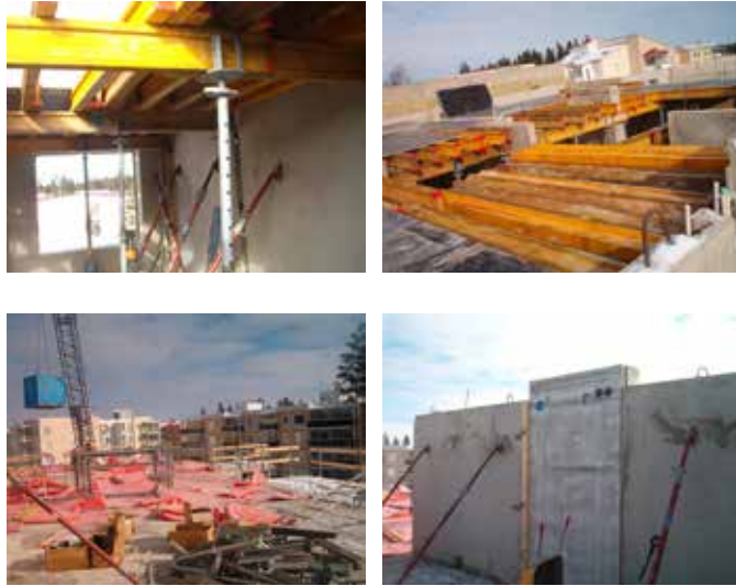
Kuva Paikallavalulaatan muottityö
